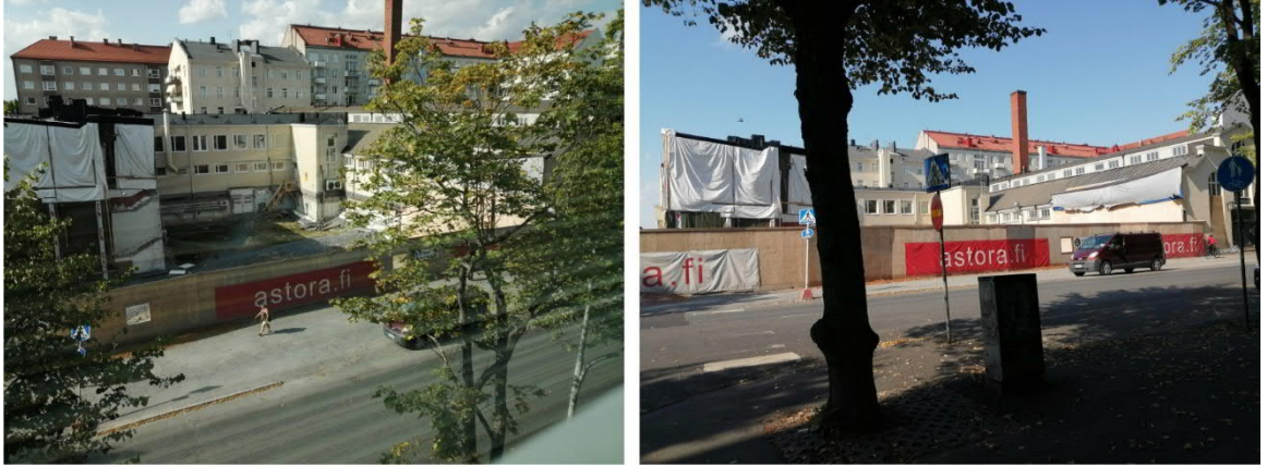
Nykytilanne Isolinnankadun puolelta, hotellirakennus purettuna (2019)
