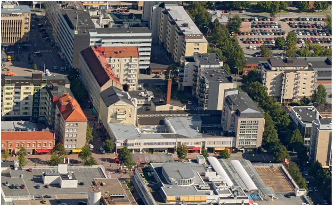
Tilanne ennen tulipaloa
