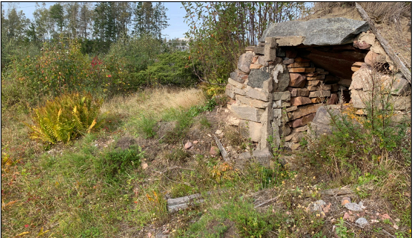
Tahkoluodon kedon vanha rakennus.
