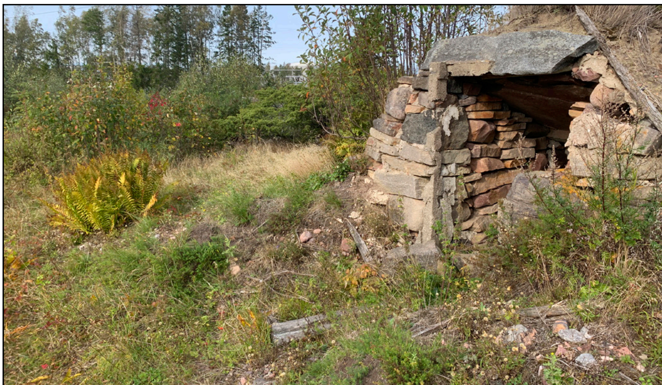
Tahkoluodon kedon vanha rakennus.
