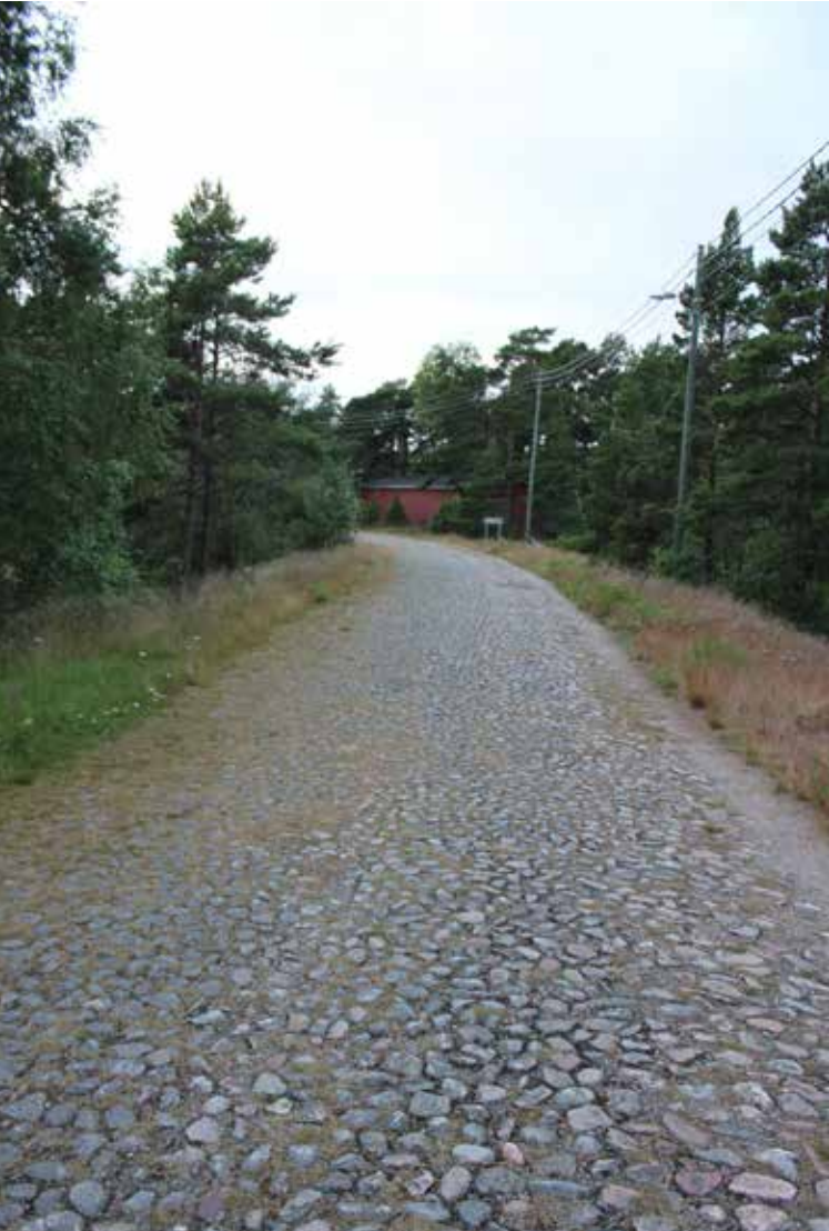
Katanpään mukulakivistä rakennettu tykkitie. Kuva: Kirsti Virkki
