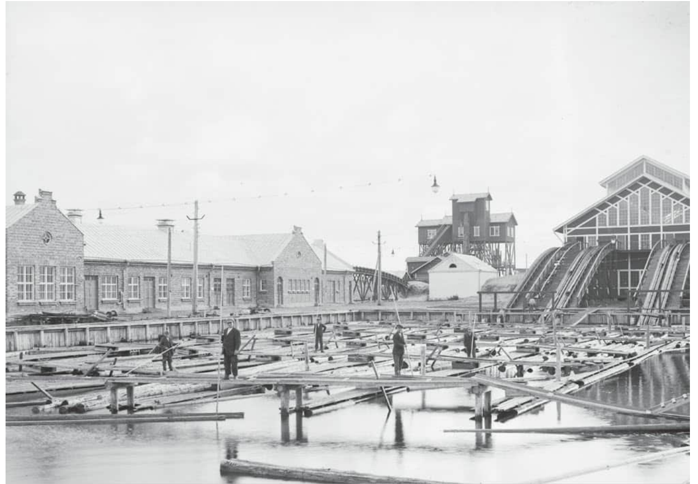
Isonsannan saha ja sen edustalla oleva tukkiallas, joka on täytetty 1960-luvulla. Vasemmalla talousrakennus ja kattilahuone. Keskellä kuvassa muuntaja. Kuva vuodelta 1927, John Englund, SMK. Isonsannan sahan rakennushistoriaselvitys, Sanna Ihatsu – CasaCo Studio Oy
