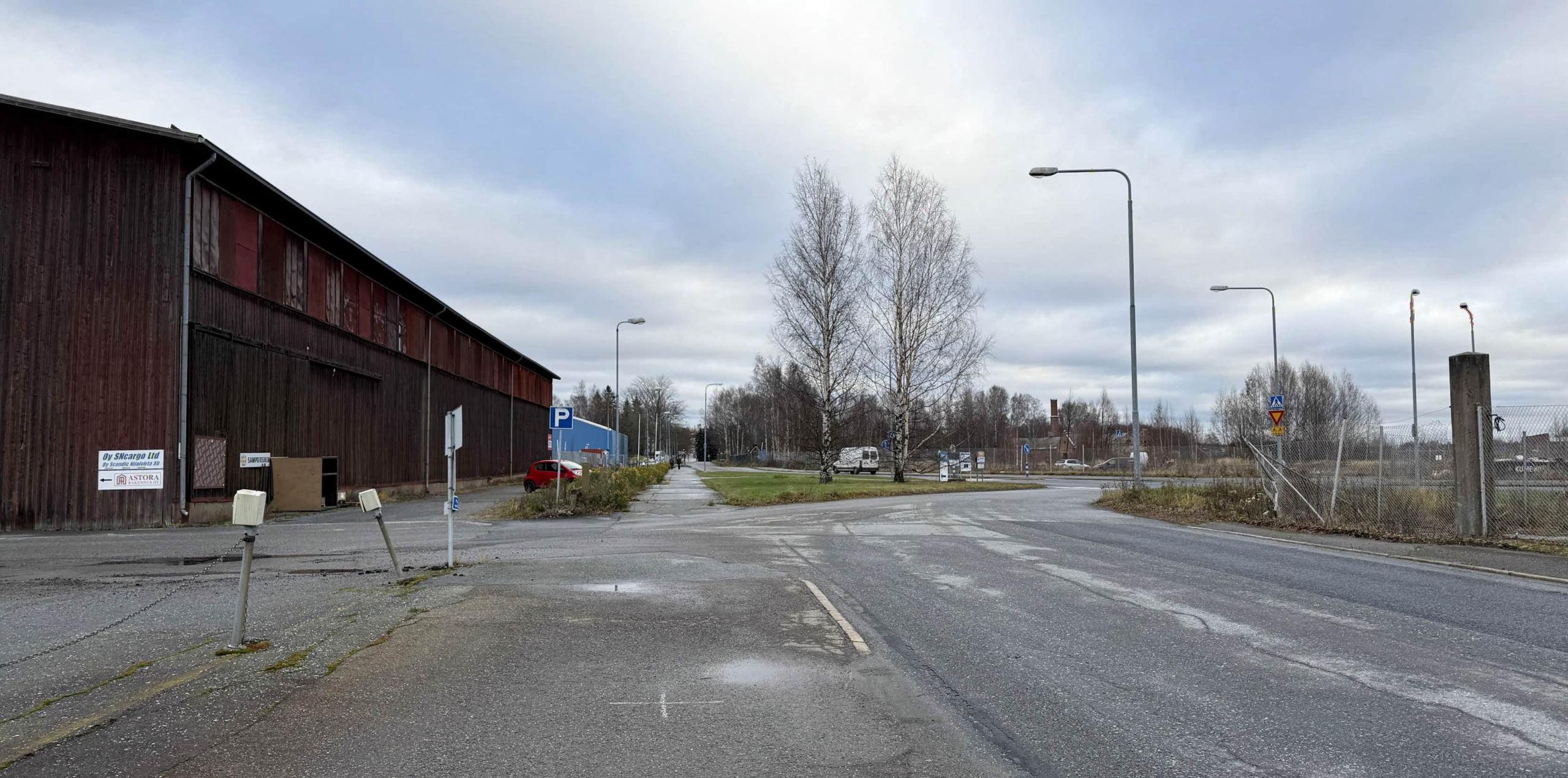
13. Varastorakennus Konepajanrannan varrella, näkymä itään, taustalla Isosannan sahan talousrakennuksen piippu.
