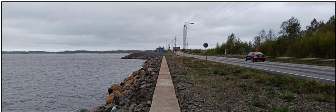
Kuva 13. Reposaaressa maantien penkeri, jossa kaapelikanavaa suojaavia laattoja käytetään jalankulun reittinä.
