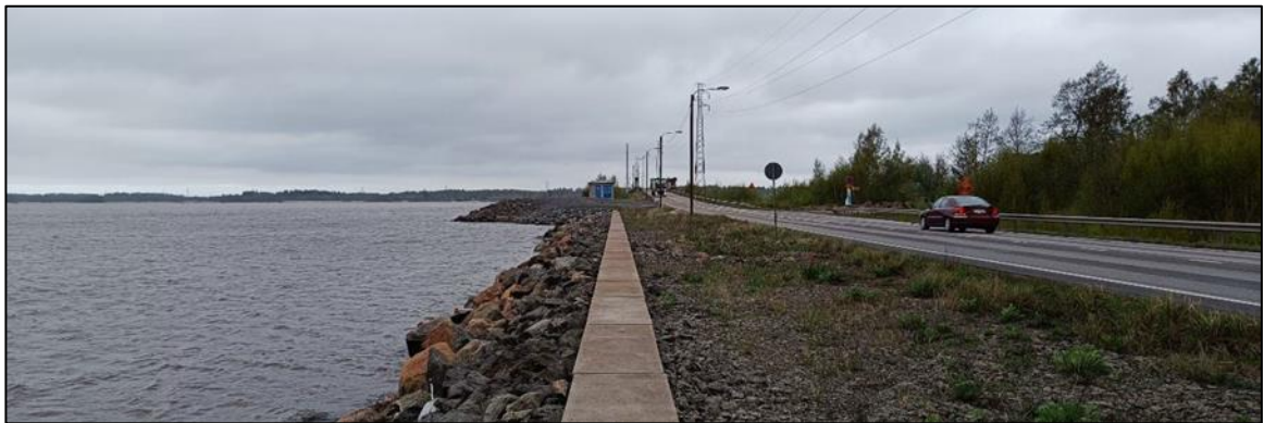
Kuva 13. Reposaaressa maantien penger, jossa kaapelikanavaa suojaavia laattoja käytetään jalankulun reittinä.
