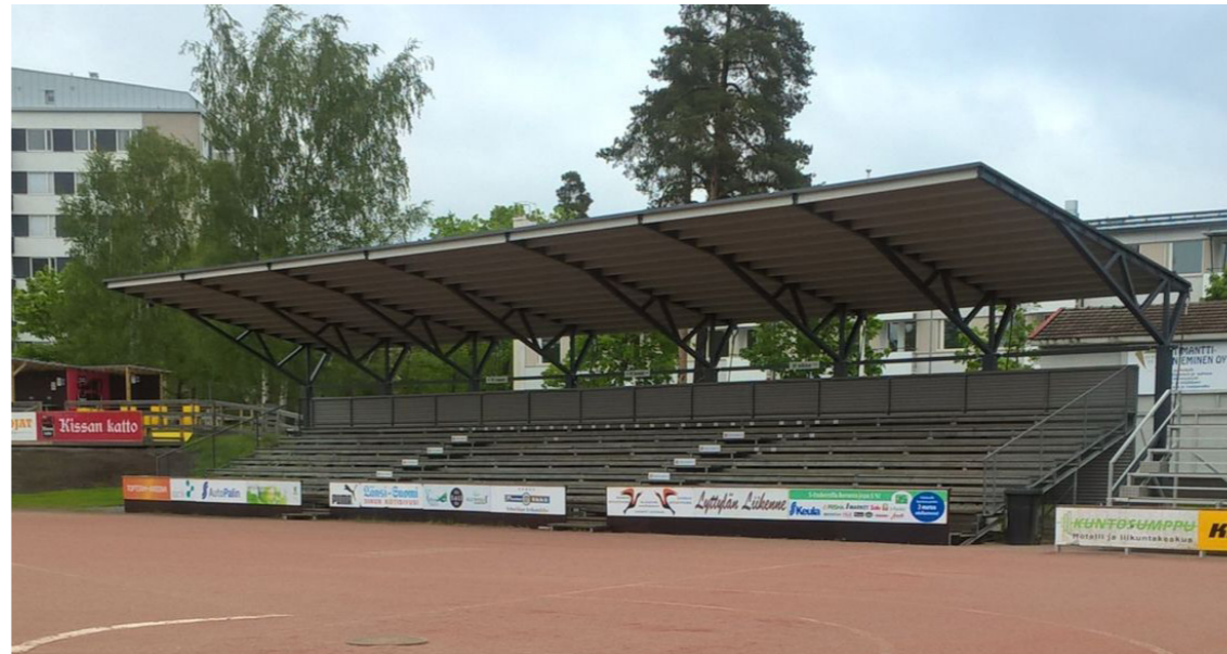
Otanlahden pesäpallostadion, Rauma, www.rauma.fi (kuva rajattu esitykseen)
