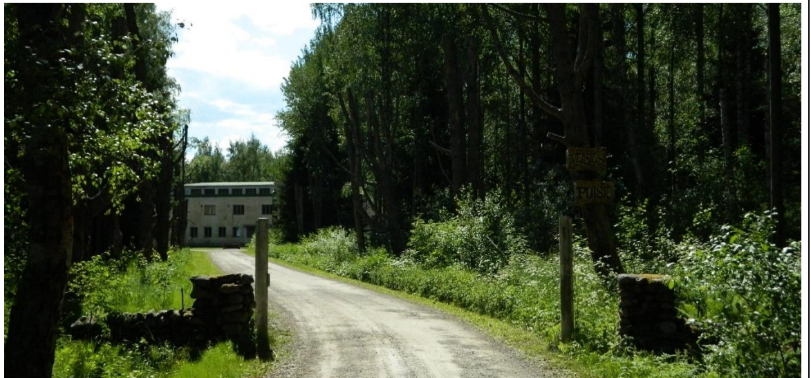
Radioasemantien lyhytaaltoaseman rakennukseen johtavasta osuudesta (kuva: DN, 2018 )
