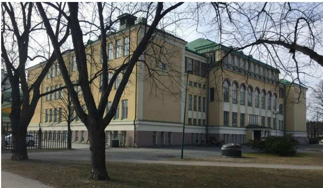
Kuva 7 Cygnaeuksen koulun pohjoinen julkisivu v. 2020. Helene Kaarnametsä
