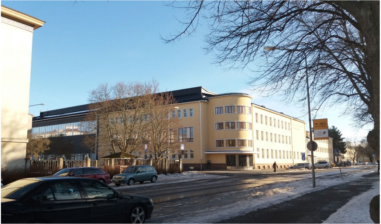
Kuva 8 Peruskorjattu PSYL koulukiinteistö maaliskuussa 2018. Pentti Klemetti
