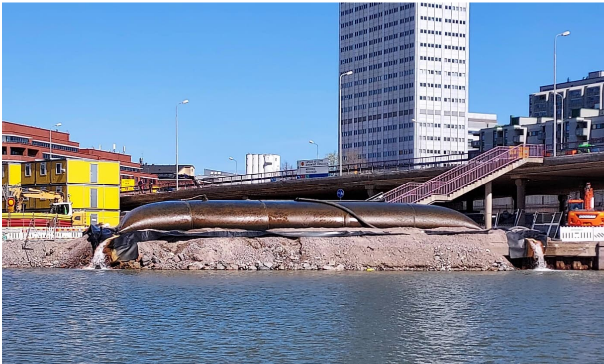
Kuva 25. Geotuubi käytössä rakennustyömaalla Hakaniemessä, Helsingissä.
