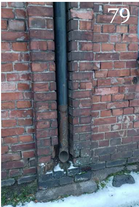
Kuva 79. Mustat, peltiset syöksytorvet ovat iäkkäät, mutta tuskin alkuperäiset.
