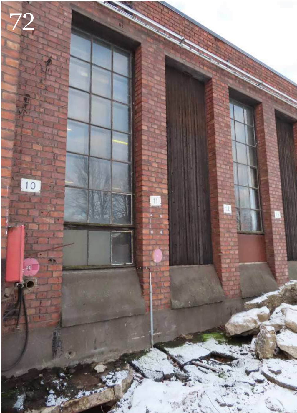
Kuva 72. Funkkisosan ikkunat ovat 21-ruutuiset puuikkunat. Ikkunoiden räystääsosa on muotoiltu mukailemaan uusgootikalaisen vanhan osan ikkunaräystäitä.
