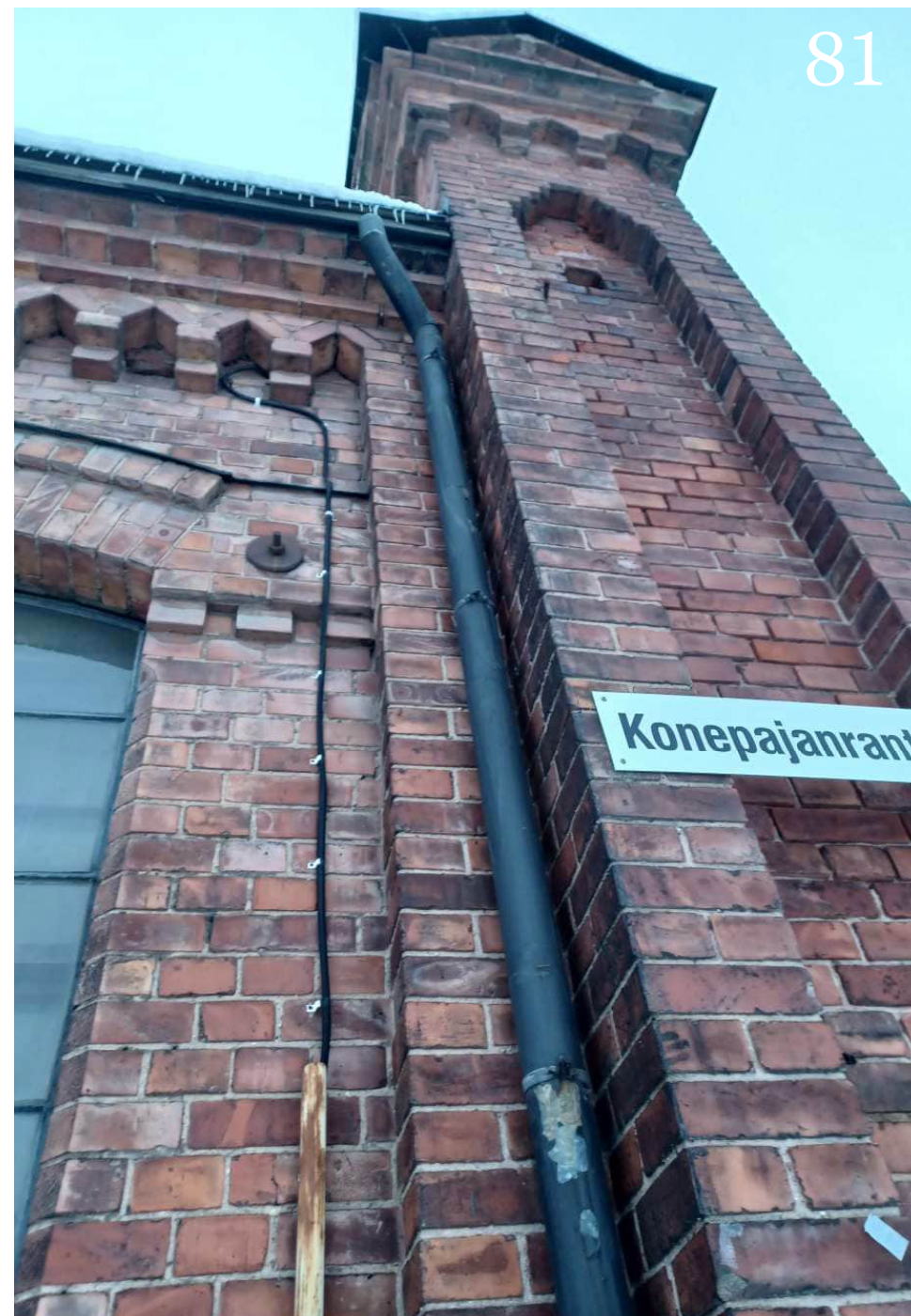
Kuva 79. Mustat, peltiset syöksytorvet ovat iäkkäät, mutta tuskin alkuperäiset.
