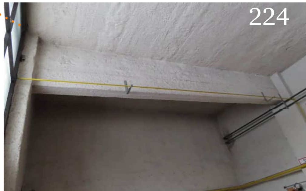
Kuva 222. Huonetila rakennuksen pohjoispuolella toimii varastotilana. Seinät ovat rapatut ja maalattu valkoiseksi, takaseinä muurattu.
