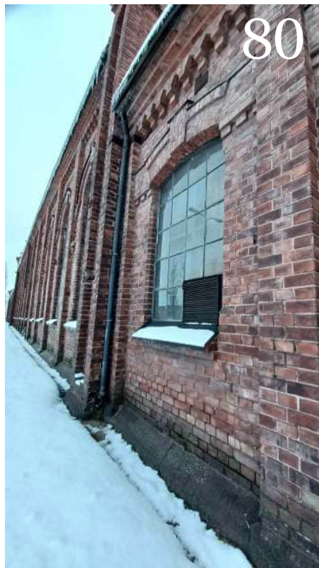
Kuva 79. Mustat, peltiset syöksytorvet ovat iäkkäät, mutta tuskin alkuperäiset.
