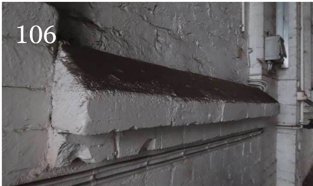
Kuva 105. Sisätiloissa näkyy kivijalkaa. Kuva 106. Ikkunamuurauksen yksityiskohta. Kuva 107. Hallitila pohjoiseen päin kuvattuna. Katossa näkyvät rautaiset kattorakenteet.
