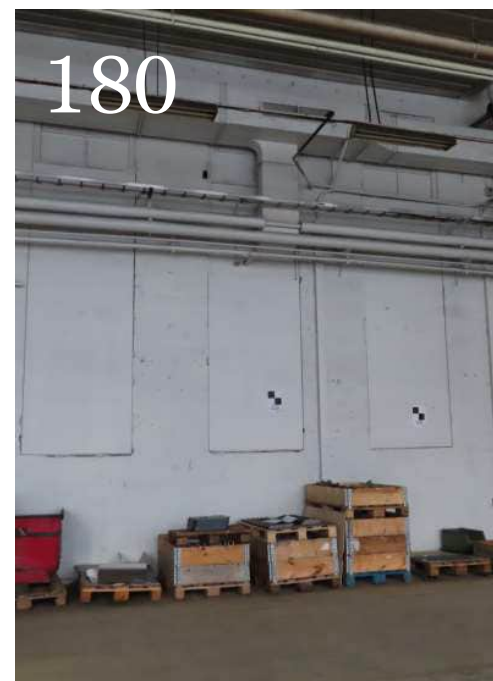
Kuva 178. Entinen höyrykeskus kuvattuna lännestä kohti itää. Itäisellä seinällä näkyvät ikkunat ja sisäänkäynti porttirakennuksen kautta. Kuva 179. Pohjoisseinän alkuperäiset ikkunat ovat jäljellä. Kuva 180. Ikkuna-aukot on levytetty toiselta puolelta. Kuva 181. 1970-luvun laajennusosassa on edelleen teollista toimintaa.
