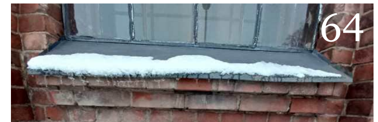
Kuva 59. Valimon vuonna 1917 valmistuneen osan ikkunoita kuvattuna tammikuussa 2023.
