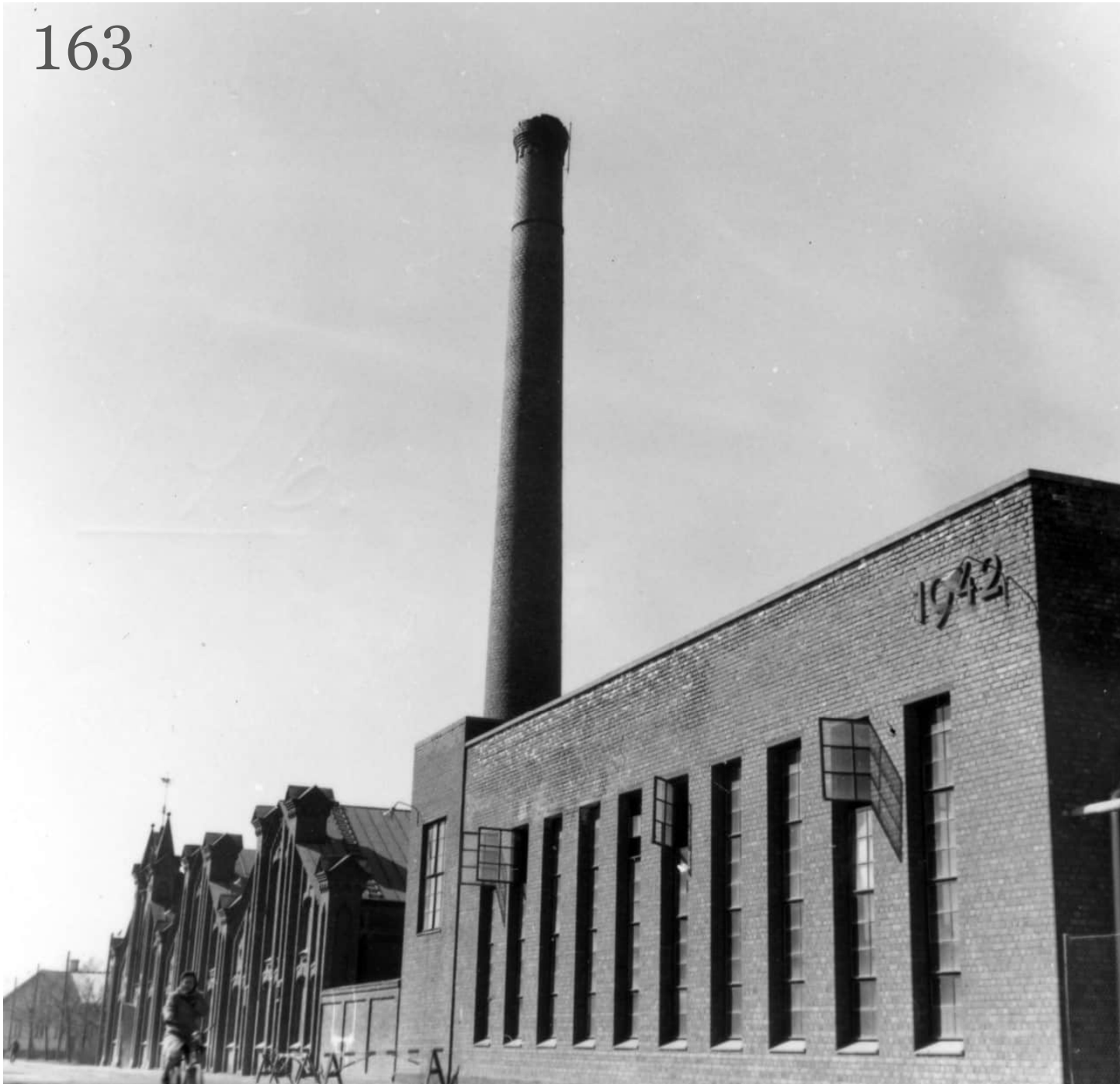
Kuva 163. Höyrykeskus 1950-1960-luvun alussa. Höyrykeskukseen kuului tornimainen osa rakennuksen länsipuolella. Torniosaan oli sijoitettu muun muassa korjaamo. Torniosa purettiin 1960-luvun alussa, jolloin valimon ja höyrykeskuksen väliin valmistui aura- ja äestehdas. Kuva: Rosenlew-museon kokoelmat.
