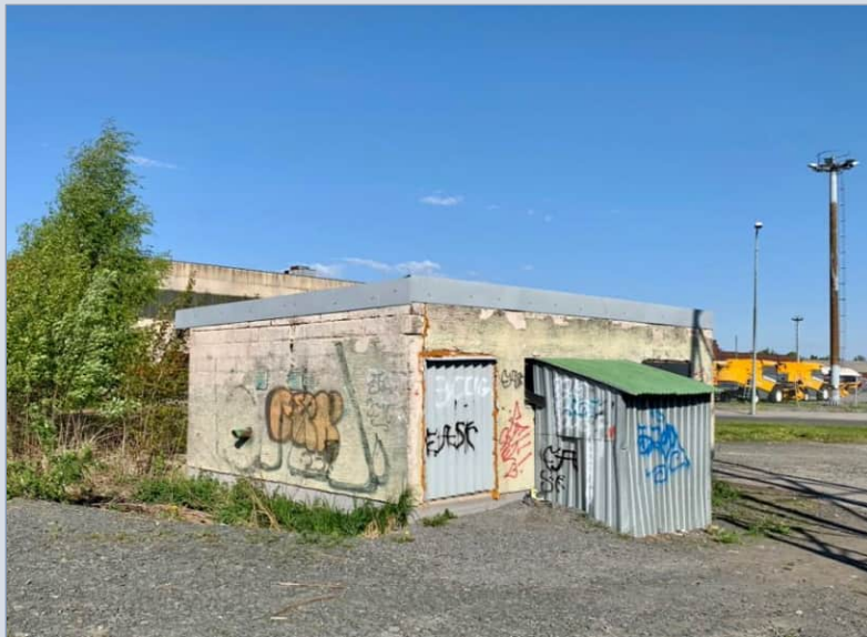
1970-luvulla valmistunut pumppaamo taustallaan puimuritehdas.
