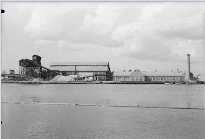
Vastavalmistuneet saha ja voima-asema vuonna 1923. Kuva John Englund, Satakunnan Museon kokoelmat.
