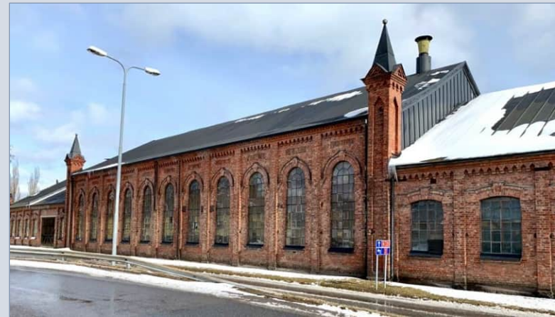
Vuonna 1903 valmistunut vanhin osa muistuttaa tornimaisine tiilipilastereineen kirkkoa. Korkeamman osan päätyikkunat on peitetty.
