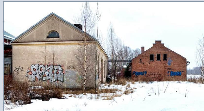
Vuonna 1922 valmistuneet muuntamo ja voima-asema lännestä.
