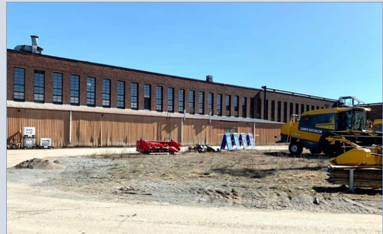
Matala, kevytrakenteinen varastokatos on rakennettu ilmeisesti 1980-luvulla Puuman länsijulkisivun eteen.
