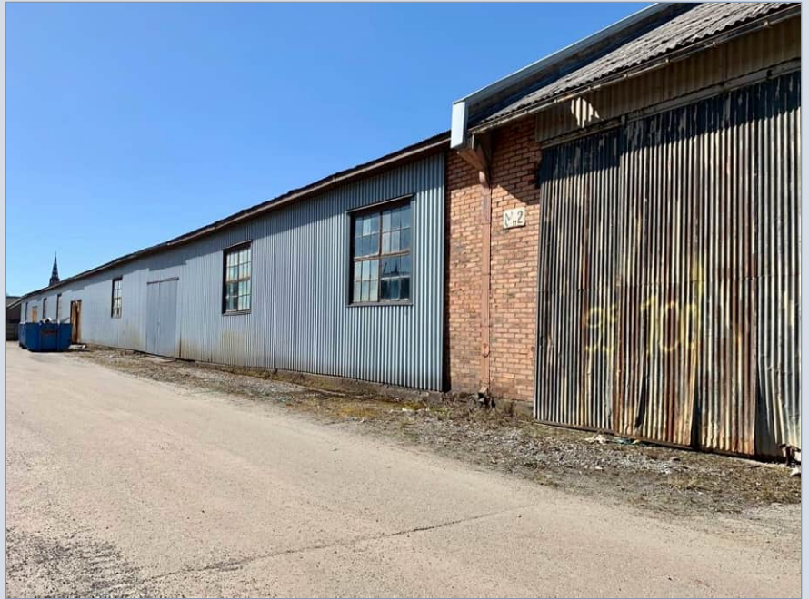
1920-luvun osan puuikkunat ovat todennäköisesti alkuperäiset.
