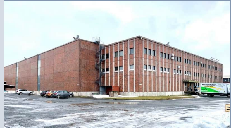
Vasemmalla vuonna 1983 valmistunut varasto-osa ja oikealla vuonna 1989 yhdellä kerroksella kolmikerroksiseksi korotettu konttoriosa.
