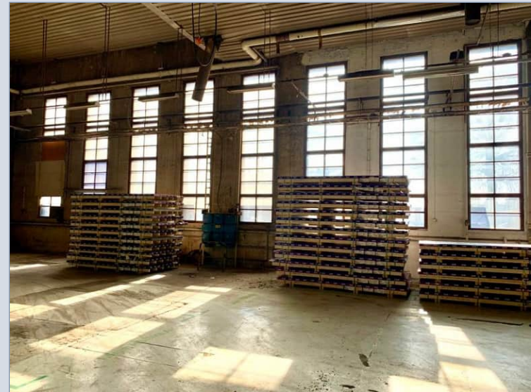
Höyrykeskuksen Teollisuuskadulle avautuva, pystysuuntainen ikkunarivi.
