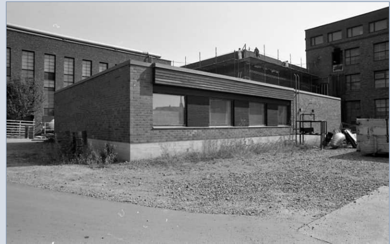
Vuonna 1973 valmistunut terveysasema oli alun perin erillinen rakennus. Kuva Jalo Porkkala 1985, Satakunnan Museon kokoelmat.
