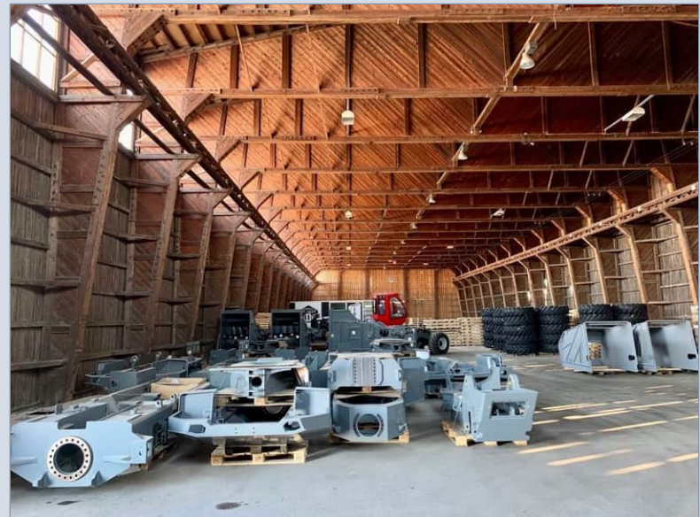
Suulin puurakenteet ovat vaikuttavat.
