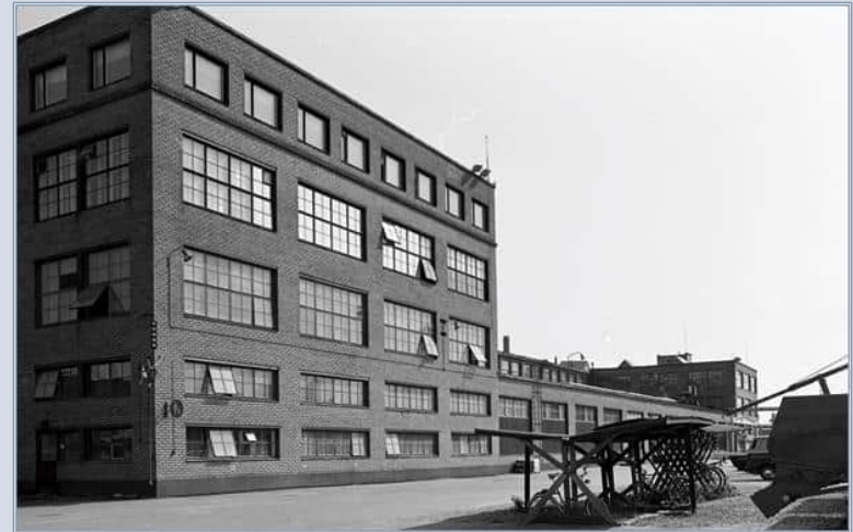
Koneistamoa laajennettiin edelleen vuonna 1956 kuvassa näkyvillä osilla. Kuva Jari Pyy 1985, Satakunnan Museon kokoelmat.
