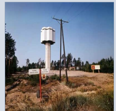
Kaanaan vesitorni (1963). Kuva Satakunnan Museon kokoelmat.
