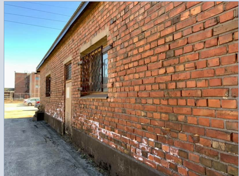
Valimon puolella holvatut ikkuna-aukot on varustettu ristikoin.
