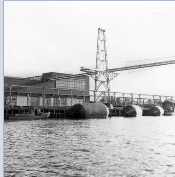
Vastavalmistuneet kattilapaja ja höyryputkisilta (1960). Kuva Satakunnan Museon kokoelmat.
