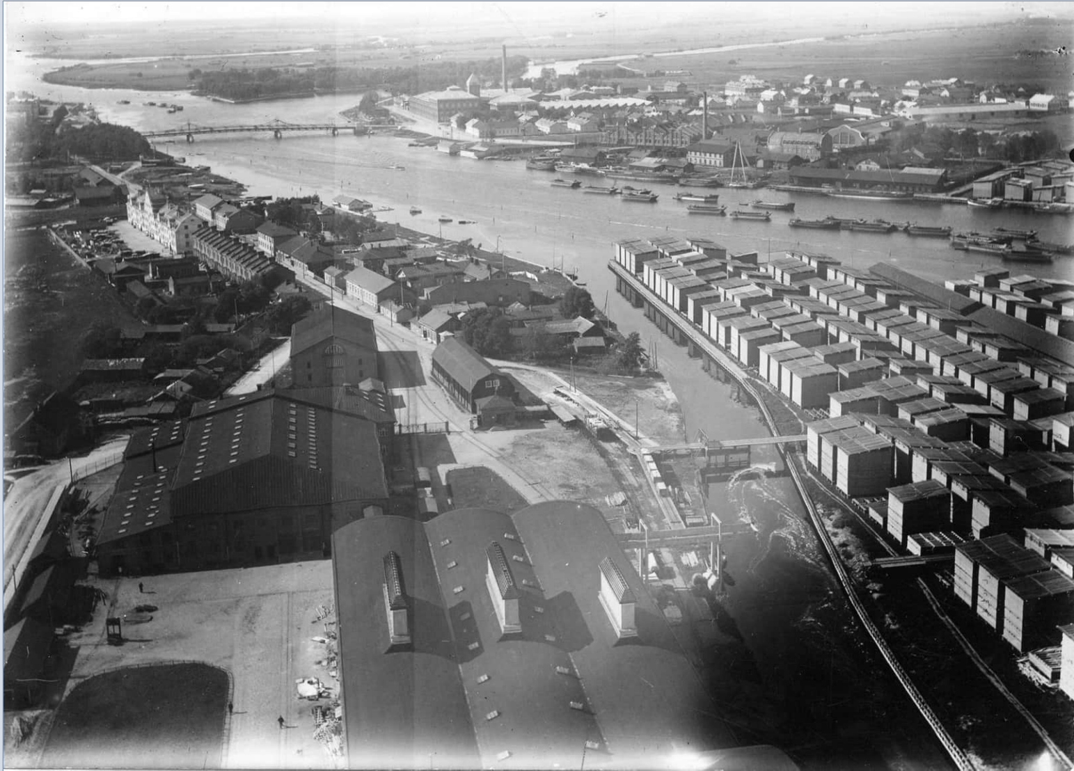
Rosenlewin omistamat teollisuuslaitokset todennäköisesti 1930-luvulla kuvattuina Kokemäenjoen molemmilla rannoilla: alhaalla etelässä Aittaluoto ja Seikun sahan lautatapulit, ylhäällä pohjoisessa Isosanta ja Porin Konepaja. Kuva Satakunnan Museon kokoelmat.
