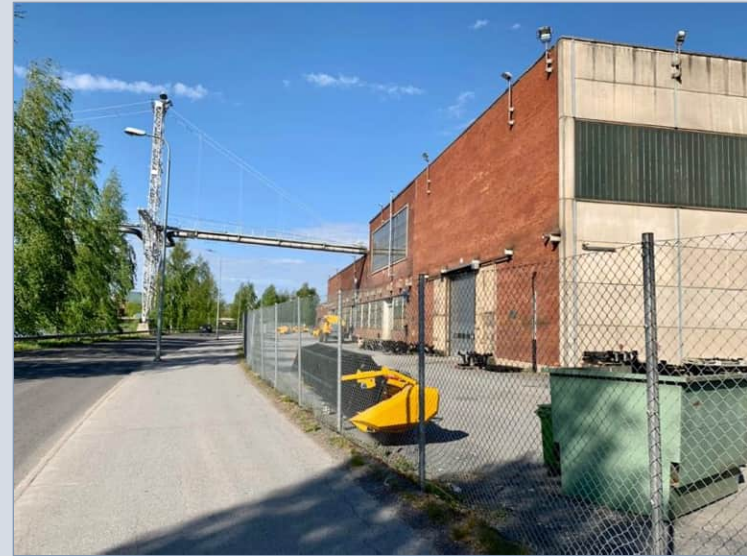
Kattilapajan (1960) ja prosessiteknisen tehtaan (1975) julkisivu etelään joelle ja Konepajanranta-kadulle. Höyryputkisilta johtaa joen yli Aittaluotoon.
