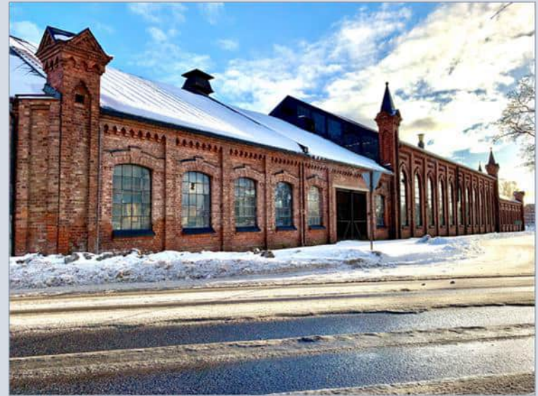
Tiilikoristelu ja –pilasterit ovat vanhan valimon ominaispiirteitä.
