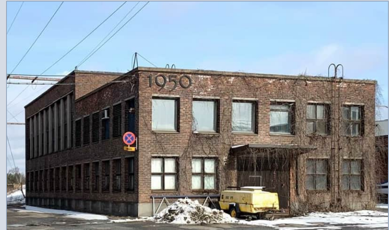
Päämuuntoaseman (1950) julkisivu etelään. Yläkerran ikkunoiden puitemallin muutos erottuu selkeästi.
