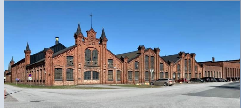
Osalan punatiilifasadi etelästä: vanha valimo, aura- ja äestehdas sekä höyrykeskus.
