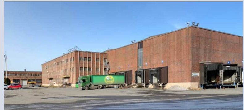
Varastoon on rakennettu myöhemmässä vaiheessa lastauslaiturit.
