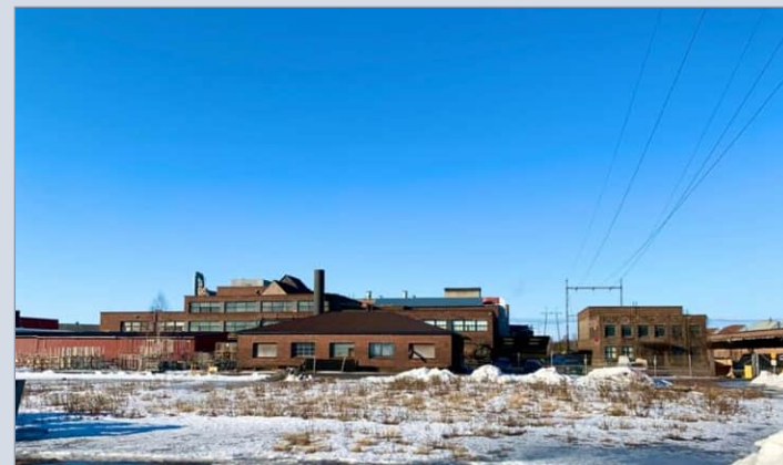
Valimo, puutavarakuivaamo ja päämuuntoasema.
