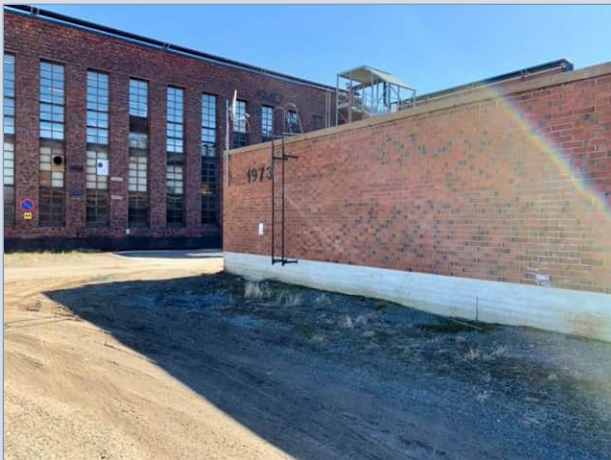
Puuma ja terveysaseman umpinainen pohjoisjulkisivu.
