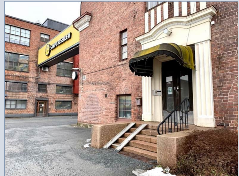
Konttorin pääsisäänkäynti. Vasemmalla koneistamon 1950-luvun laajennus ja rakennukset yhdistävä ylikulku.
