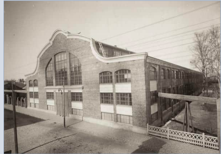
Vuonna 1917 valmistunut viilaverstas alkuperäisessä asussaan. Julkisivun yläosan koristeellista muotoa on korostettu rapatulla räystäslistalla. Kuva Suomen Metsämuseo Lusto.
