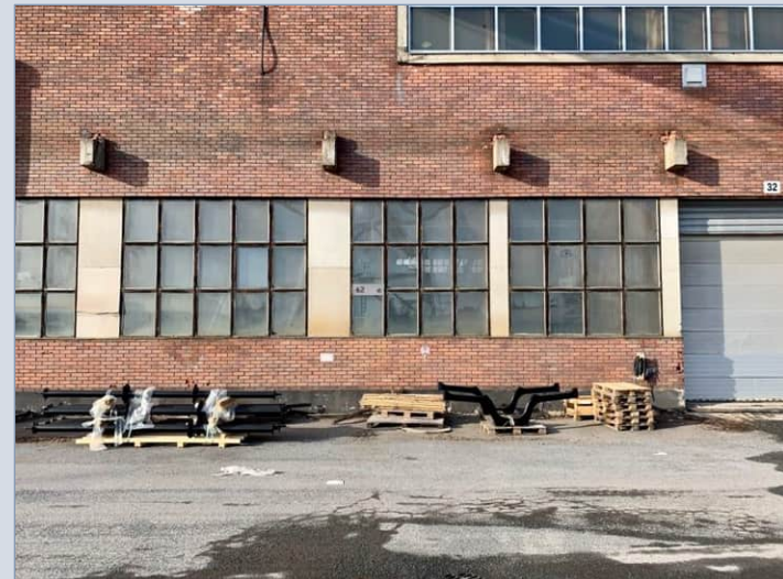
Kattilapajan pohjakerroksen ikkunanauha koostuu moniruutuisista puuikkunoista.
