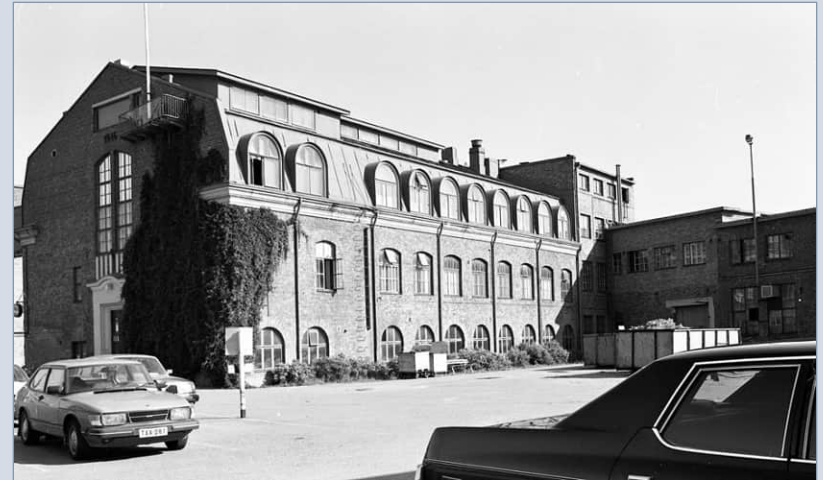
Kulmassa näkyvä nelikerroksinen laajennus on ilmeeltään alkuperäistä osaa huomattavasti riisutumpi. Ullakkokerrosta on korotettu vuonna 1950 pulpettikattoisella osalla. Kuva Jalo Porkkala 1985, Satakunnan Museon kokoelmat.
