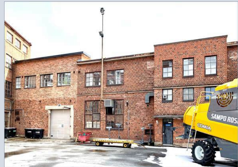
Pajan (1935) julkisivu länteen. Konttorin nelikerroksiseen laajennukseen liittyvää kaksikerroksista osaa on tiilien väristä päätellen korotettu ja julkisivuun on asennettu uusi nosto-ovi.
