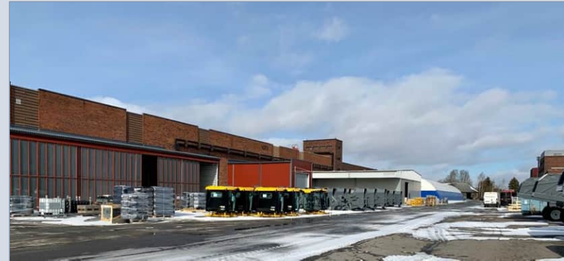
Itäjulkisivun laajennukset ovat 1970- ja 1980-luvuilta.
