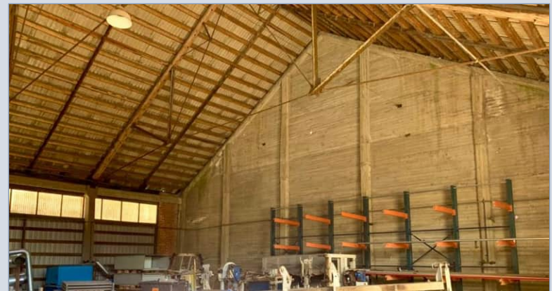
1950-luvun laajennusosan kattorakenne ja betonista valettu palomuuripääty.
