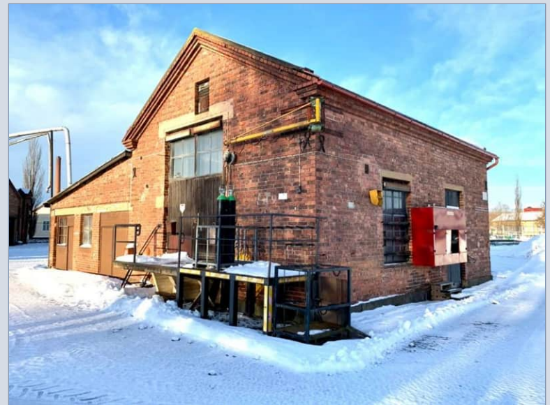
Polttoainevarasto kaakosta. Lastauslaituri on poistettu itäisivulta.
