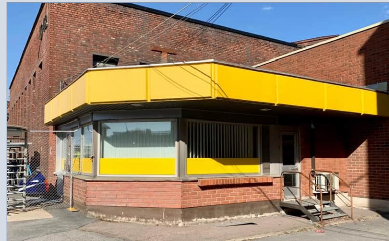
Porttirakennus sijaitsee höyrykeskuksen (1942) ja myöhemmän tehdaslaajennuksen (1985) kulmassa.
