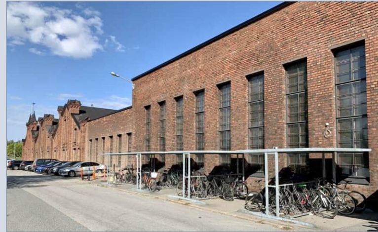
Vanha valimo (1903-1919), aura- ja äestehdas (1964) sekä höyrykeskus (1942) muodostavat Teollisuuskadun varrelle Osalana tunnetun, arkkitehtuuriltaan edustavan ja ajallisesti kerroksellisen rakennuskokonaisuuden.
