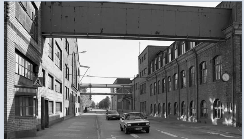
Konttori ja sen korkeammaksi nouseva nelikerroksinen laajennusosa Teollisuuskadun etelälaidalla (kuvassa oikealla). Kuva Jalo Porkkala 1985, Satakunnan Museon kokoelmat.
