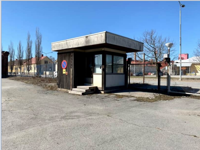
Rakennus on valmistunut 1960-luvulla Valajankadun varrelle Rosenlewin tehdasalueen läntiseksi porttirakennukseksi.
