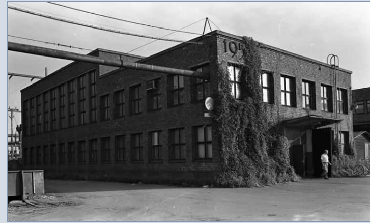
Päämuuntoasema vuonna 1985. Kuvassa aukotus ja ikkunoiden puitemalli ovat alkuperäisessä asussaan. Kuva Jalo Porkkala, Satakunnan Museon kokoelmat.
