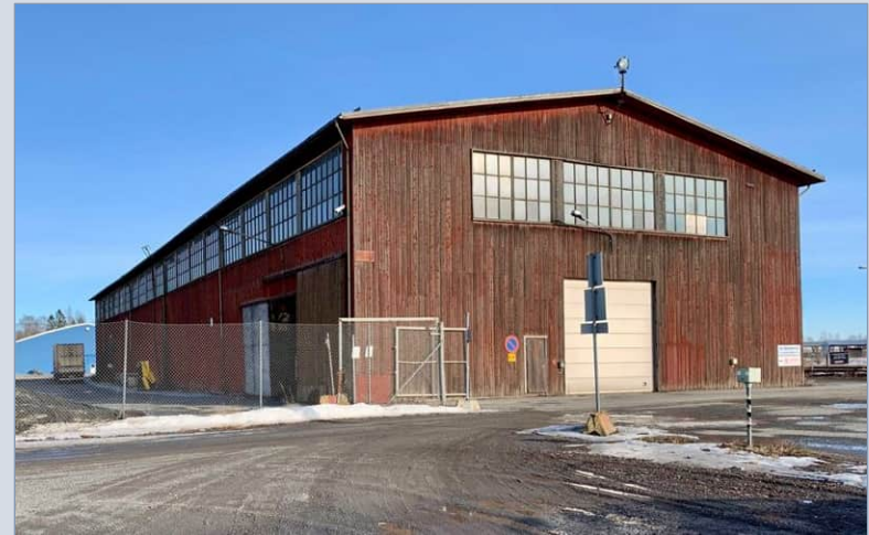
Moniruutuisilla ikkunoilla varustettu suuli luoteesta. Päätyyn on asennettu metallinen nosto-ovi.
