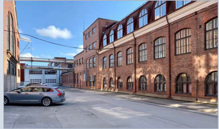
Paja, pannuverstas, konttorin nelikerroksinen laajennus ja konttori muodostavat Teollisuuskadun etelälaidalle yhtenäisen punatiilijulkisivun.
