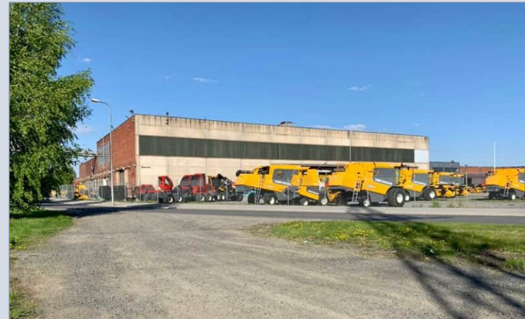
Konepaja-alueen maisemallisena rajana toimivan prosessiteknisen tehtaan laajennuksen (1975) ilmeeltään ankaran pelkistetty itäjulkisivu.
