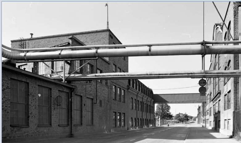
Funktionalistiset paja (1936), pannuverstas (1935) ja konttorin laajennus (1935/1950) eroavat Teollisuuskadun varrella kaari-ikkunoilla varustetusta konttorista (1916).
