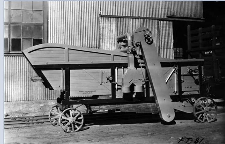
Puimakonevarasto ja Sampo-puimakone vuonna 1943. Huomaa varhainen peltiverhous. Rosenlew-museon kokoelmat.
