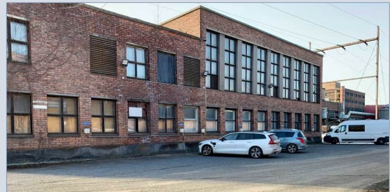
Rakennuksen korkeammassa pohjoisosassa toimineen muuntamon tekninen laitteisto on poistettu. Osa ikkuna-aukoista on peitetty metalliritilöin.
