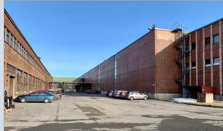
Kodinkonetehtas (1952-1969) ja keskusvarasto (1983) on yhdistetty toisen kerroksen korkeudessa kulkevalla tunnelilla, jota pitkin kodinkoneet on kuljetettu tehtaasta varastoon.
