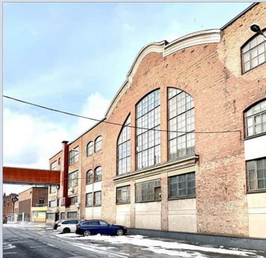
Viilaverstas nykyasussaan. Huomaa korotuksen vaikutus rakennuksen siluettiin.
