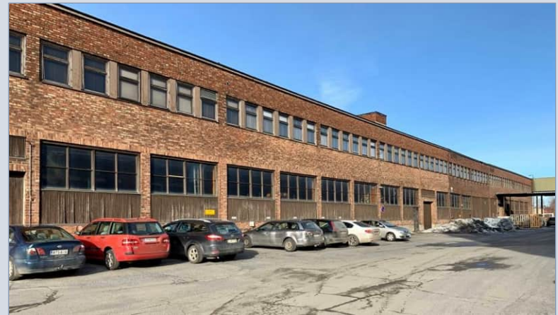
Vuosina 1952, 1955 ja 1969 rakennetun kodinkonetehtaan voimakkaan horisontaalinen, ominaispiirteiltään melko hyvin säilynyt eteläjulkisivu.
