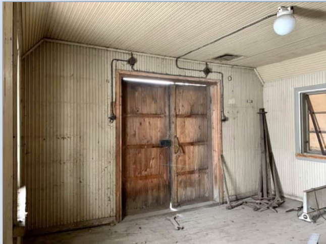
Alkuperäisessä asussaan säilynyt sisätila panelointineen.
