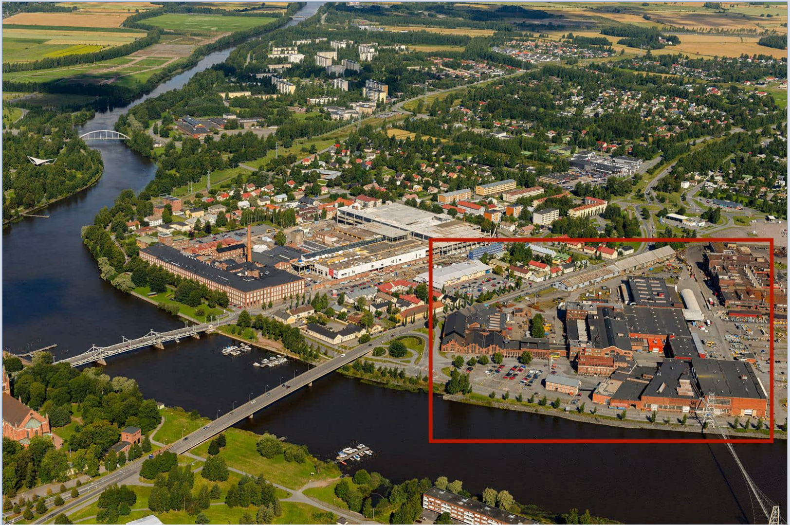
Konepaja ilmasta kesällä 2013. Kuvan oikeassa alakulmassa näkyy myös Konepajalta joen yli Aittaluotoon johtava, kaupunkikivallisesti merkittävä höyryputkisilta (ks. 4.14.). Kehyksen oikeassa yläkulmassa Componentan valimo. Kuva Vallas Oy / Porin kaupunkisuunnittelu.
