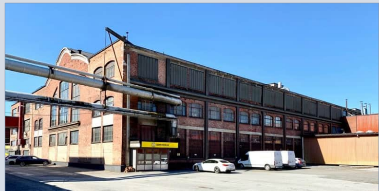
Viilaverstaan sivuosia on korotettu kolmannella kerroksella 1930- ja 1950-luvulla. Korotuksen ikkunat on itäjulkisivulla peitetty .
