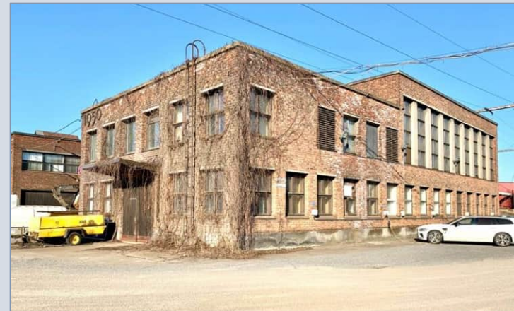
Vuonna 1950 valmistunut entinen päämuuntoasema on nykyisin vailla käyttöä.
