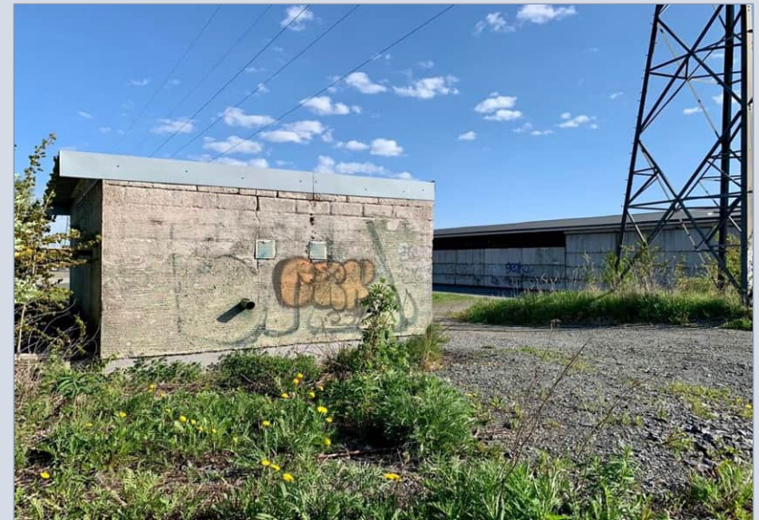
Pumppaamo ja varasto sijaitsevat ranta-alueella lähellä toisiaan.
