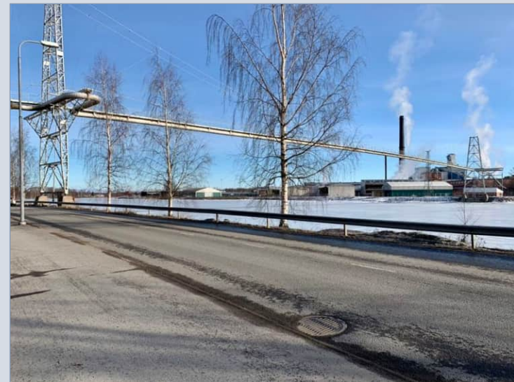
Höyryputkisilta johtaa Konepajanranta-kadun ja Kokemäenjoen yli Aittaluotoon.
