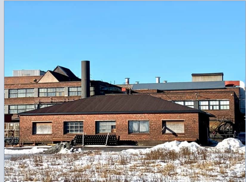
Julkisivu etelään, taustalla uusi valimo (Componenta). Osa ikkunoista on levytetty umpeen.
