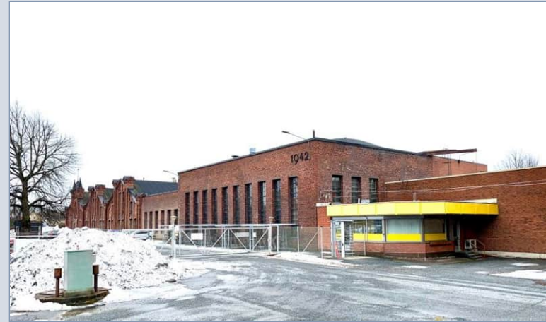
Porttirakennus vasemmalla puolellaan höyrykeskus.
