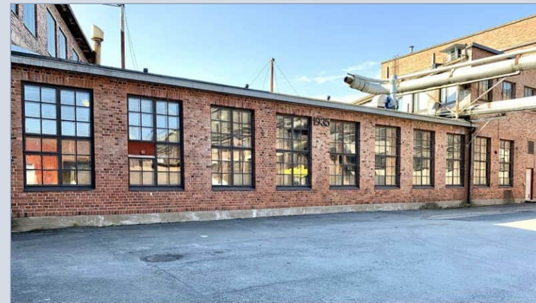
Pajan (1935) matala julkisivu pohjoiseen.
