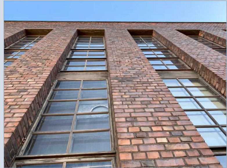
Puuman julkisivuja leimaavat kapeat, korkeat ikkunat.
