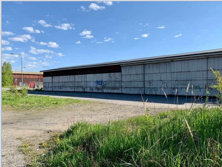
1940-luvulla valmistunut varasto on rakennettu todennäköisesti Rosenlewin puotalotehtaan käyttöön.
