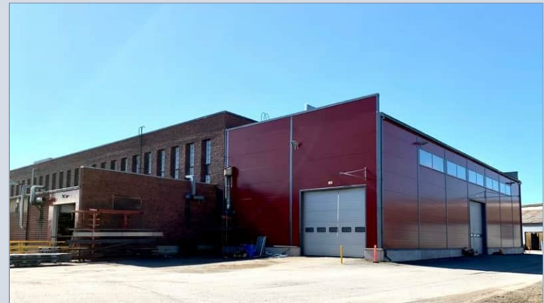
Rakennuksen itä- ja pohjoisjulkisivulle on rakennettu laajennukset 1970- ja 2000-luvulla.
