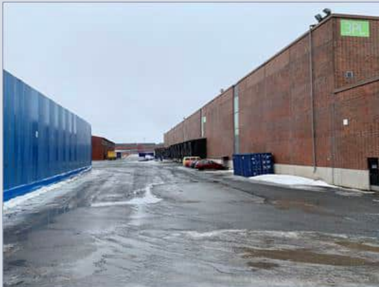
Pystysuuntaisilla ikkunanauhoilla varustettu keskusvarasto on ilmeeltään suljettu.
