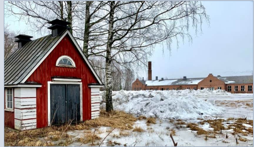
Porttirakennus ja voima-asema Konepajanranta -kadulta.
