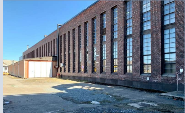
Puuman symmetrinen, kapeilla ja moniruutuisilla puuikkunoilla varustettu länsijulkisivu.
