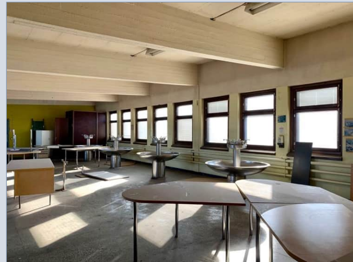
Toisessa kerroksessa sijaitsee toimistotilojen lisäksi työntekijöiden pesuhuone.
