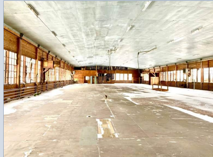
Toinen kerros koostuu pääosin avoimesta tilasta. Sen laskettu sisäkatto on verhottu peltilevyin.
