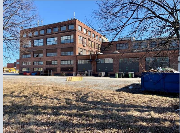
Koneistamon vuonna 1956 valmistunut laajennus lännestä sisäpihalta. Rakennuksessa on 1940-luvun koneistamon tavoin räystäätön tasakatto. Ylimmässä kerroksessa on toiminut Konepajan ruokala.
