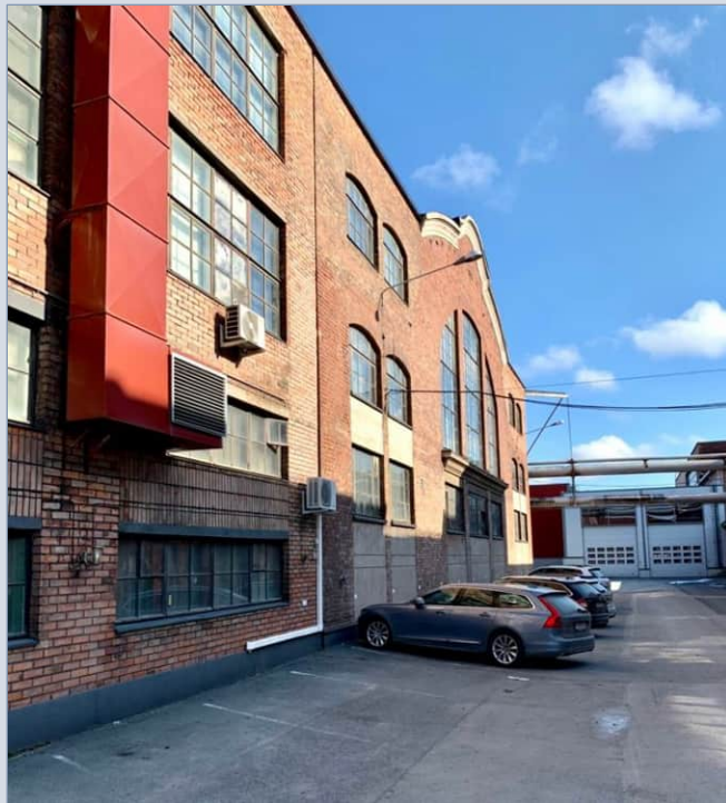
Viilaverstas vasemmalla puolellaan vuoden 1956 laajennusosa. Rakennukset muodostavat pitkän, vanhaan valimoon saakka ulottuvan yhtenäisen punatiilijulkisivun Teollisuuskadun varrelle.
