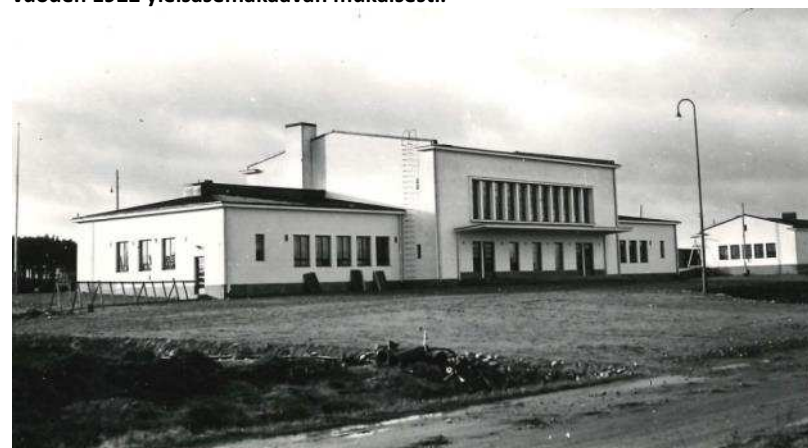
Asemarakennus ja pikatavara-asema pian valmistumisen jälkeen vuonna 1938.
