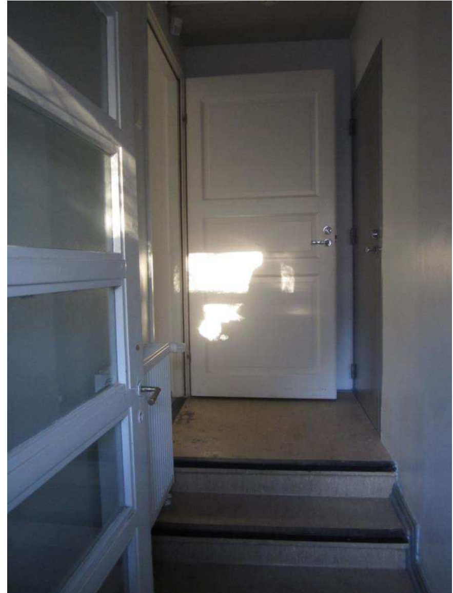
Kaakkoispäädyn eteinen. Lasitettu ovi on alkuperäinen.
