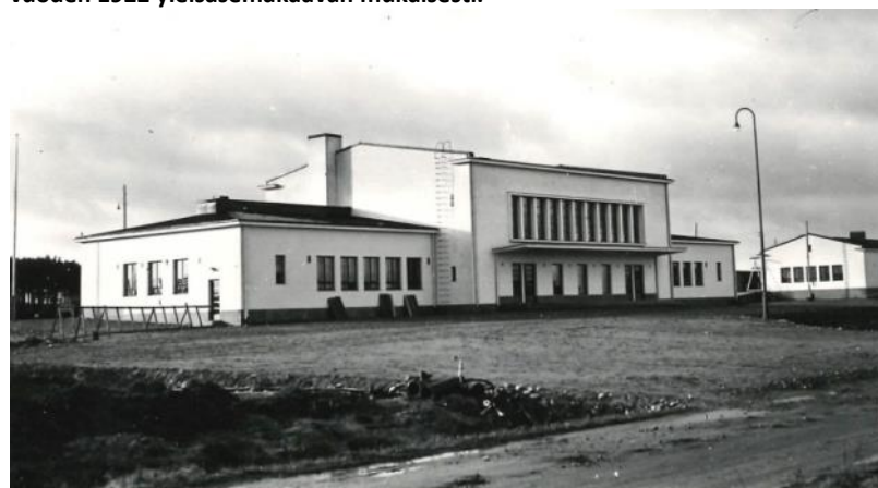
Asemarakennus ja pikatavara-asema pian valmistumisen jälkeen vuonna 1938.
