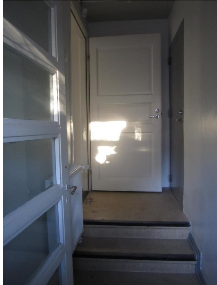
Kaakkoispäädyn eteinen. Lasitettu ovi on alkuperäinen.
