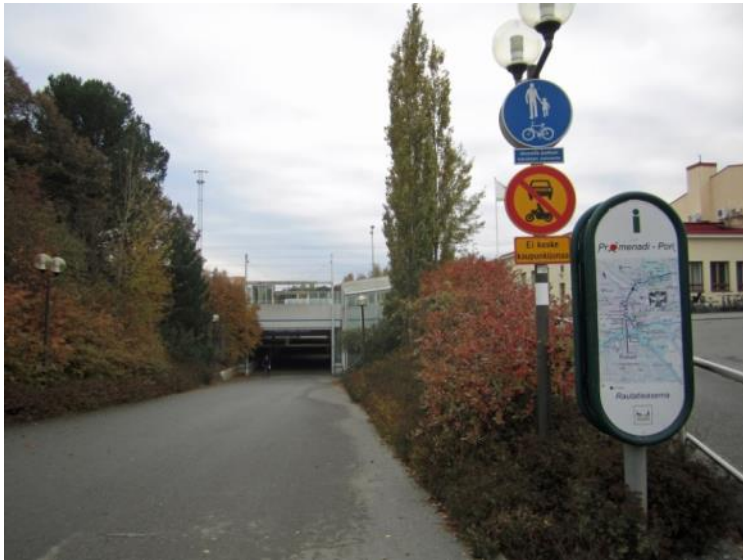
Sisäänkäynti Porttaali-tunneliin kaupungin suunnasta.
