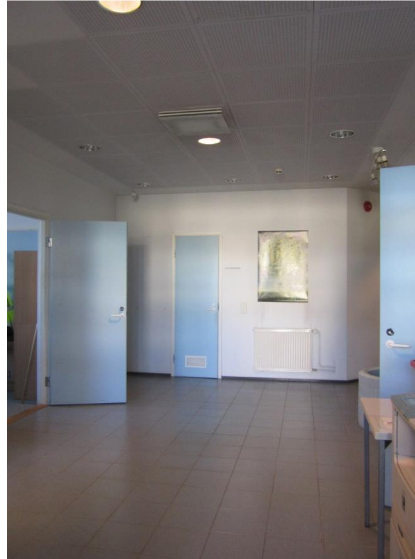
Luoteispäädyn aula, entinen tavaratila on rakennettu kokonaan uudelleen.
