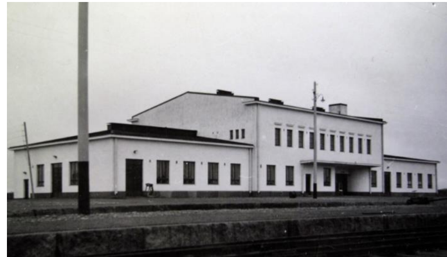
Ratapihan puolella luoteispäässä ollut sisäänkäynti akkumulaattorihuoneeseen on myöhemmin korvattu ikkunalla ja postivaunu-huoneen ovi on siirretty lähemmäksi kaakkoispäätä.
