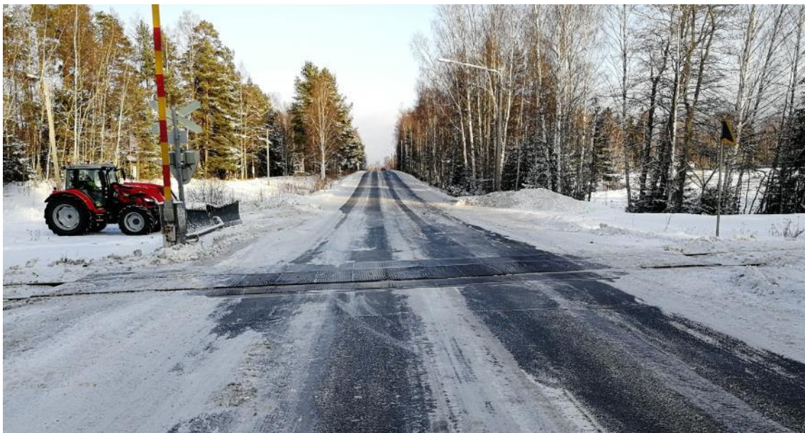
Pihlavan yhdistysten tasoristeys Harry Gullichenintellä (kuva: Väyläviraston tasoristeyspalvelu)
