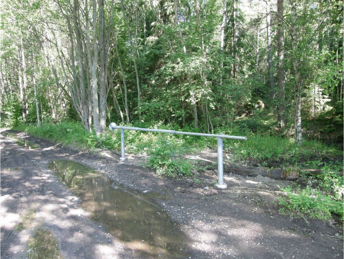
Kuva 33. Ruosniemi 2:lle on asennettu puomi.
