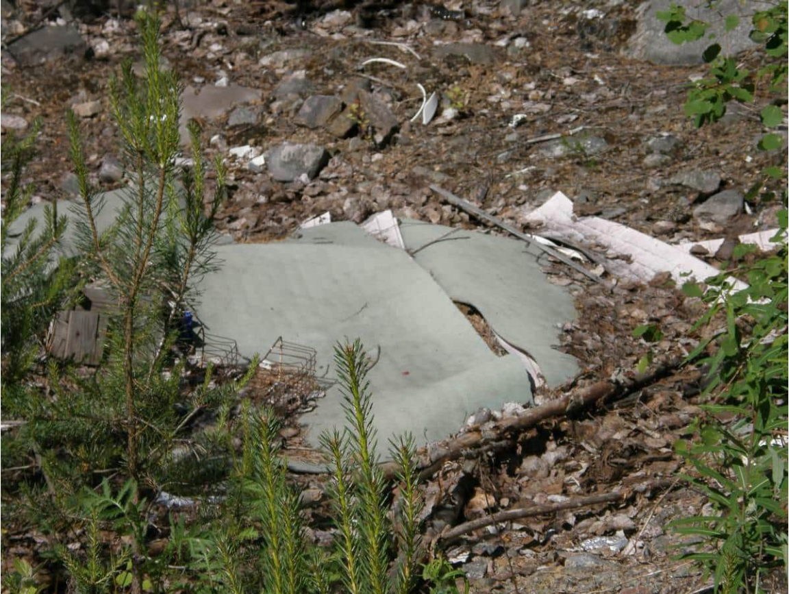
Kuva 1. Ainoa kohta Keskisjoen kaatopaikan rinteestä, jossa jätettä näkyy peittokerroksen läpi .
