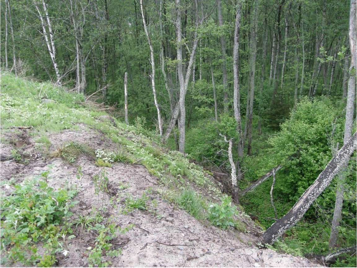
Kuva 23. Kirrisannan jätepenkereen reunaosaa.
