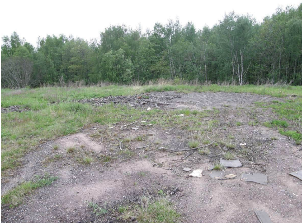
Kuva 22. Kirrisannan jätepenkka päältä
