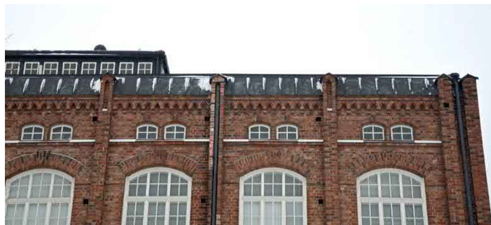
Itäkulman julkisivun yläosaa, räystään hammaslistaa. Pilastereiden jatkuminen yli räystään ja terävä pääte on uusgotiikkaan liittyvä piirre, 1910- ja 1930-lukujen muutosten jyrkkä kattomuoto vie osansa piirteen vaikuttavuudesta. Ensimmäisessä vaiheessa, 1890-luvulla tehtaiden kattomuotona oli vielä loiva aumakatto.
