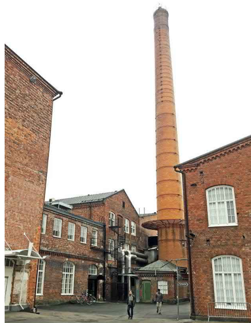
Voimalaitoksen pohjoisjulkisivua tehdasalueen sisäosaan päin. Rakennuksen 1920/30-luvun korotus näkyy tässäkin selkeästi omana kerroksena ja ikkunajakona.
