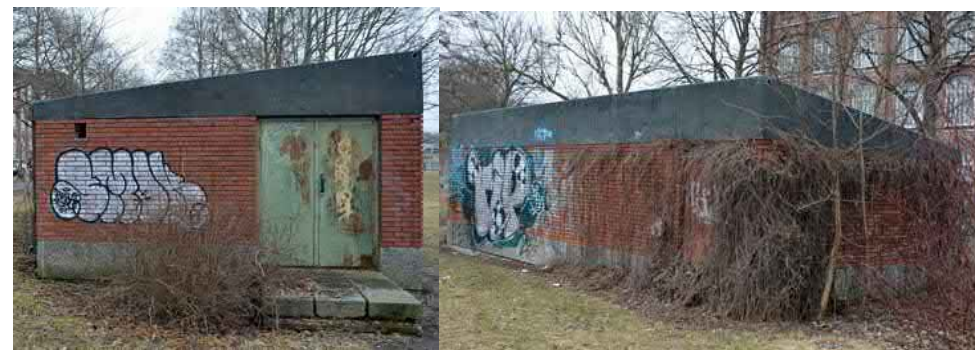
Puistoalueella sijaitseva pumppurakennus lännestä ja kaakosta.
