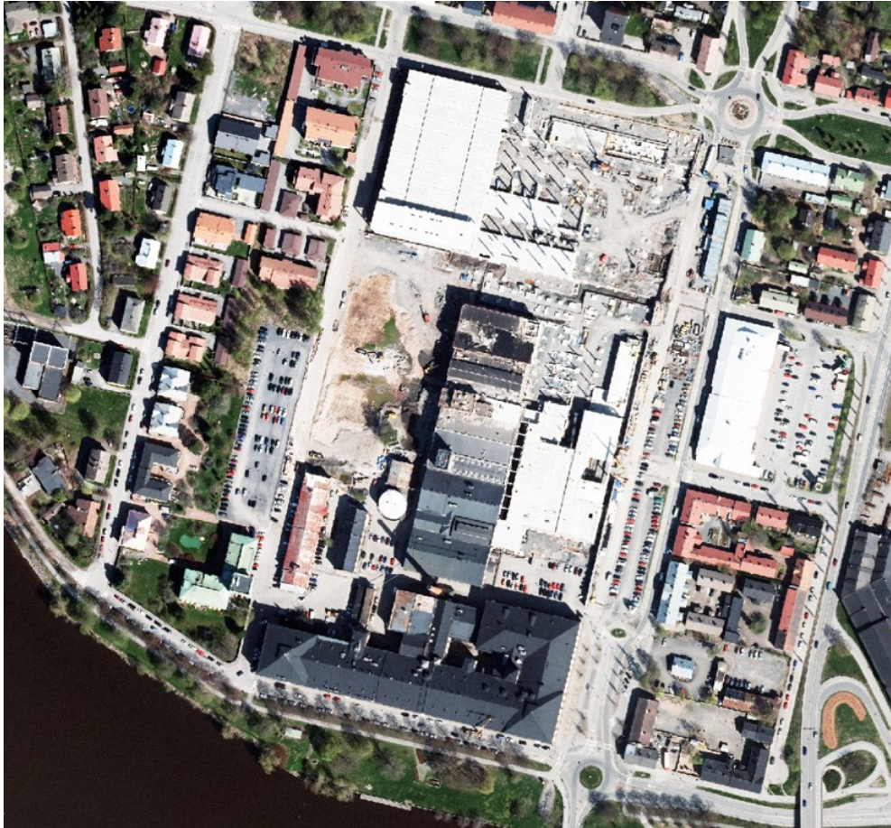
Ilmakuva vuodelta 2013. Kauppakeskus Puuvillan rakentaminen on meneillään Värjäämö- rivin pohjois- ja itäpuolella. Värjäämörivin länsi- ja luoteispuolelta on purettu Uusi keh- räämö ja korjauspaja (Pentti Ahola, 1952), puuvillavarasto (A. Pesu, 1938), kutomo ja kang- asvarasto (A. Pesu, 1942) sekä lähtevän tavaran lastaus (Esko Suokas, 1961). Lähde: Porin kaupungin www-sivut.
