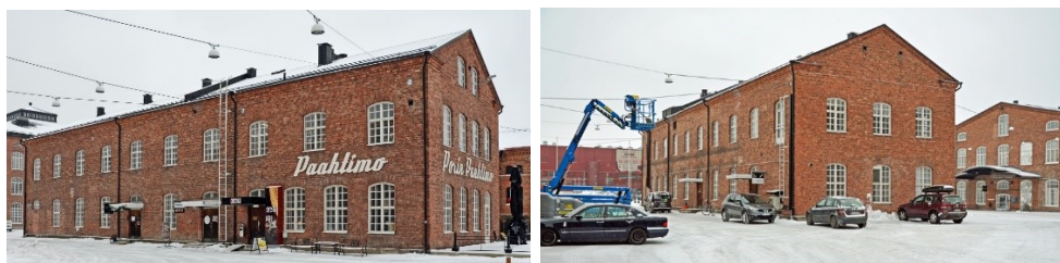
Vasemmalla oleva kuva on otettu koillisesta lounaaseen päin. Julkisivukuvaan merkitty pakkaamon ovi on jossain vaiheessa korvattu ikkunalla. Oikealla oleva kuva on otettu lounaasta koilliseen päin.
