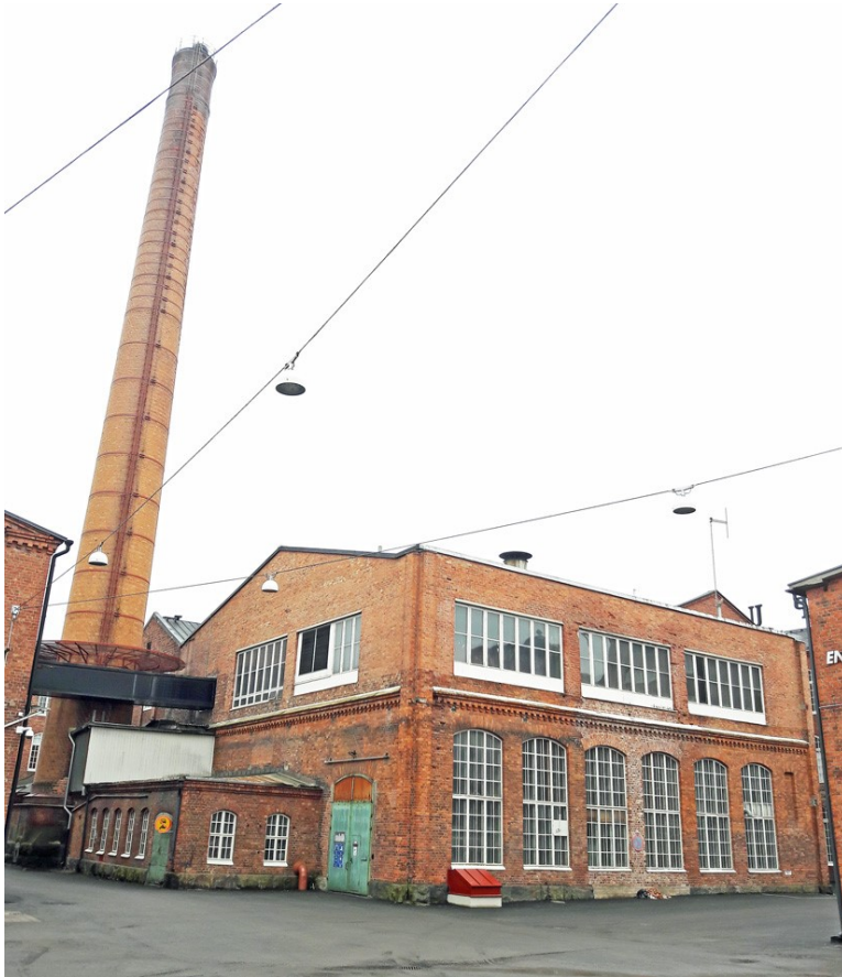
Voimalaitos luoteesta kuvattuna, alaosa on alkuperäistä, August Krookin suunnittelemaa voimalaitosta. Rakennuksen 1950-luvun korotus näkyy selkeästi omana kerroksena ja ikkunajakona. Piipun juurella oleva matala osa on pumppaamon laajennus on 1920-luvun alkupuolelta.
