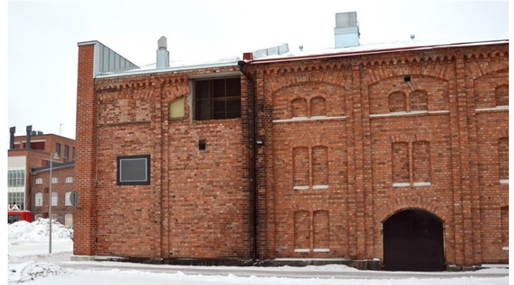
Pohjoispäädyssä on vielä nähtävissä vuoden 1927 jatko-osaa kahden pilarivälin verran. Laajennuksen suunnitteli arkkitehti Lindahl, noudattaen uskollisesti Krookin luomaa julkisivujäsentelyä.
