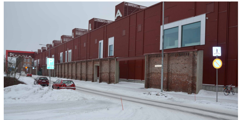
Vanhan ja uuden mittakaavan muutos korttelin pohjoispäässä näkyy hyvin Siltapuistoka- dun varrella. Kauppakeskuksen tieltä purettiin myös kutomon pohjoisseinä, joka muo- dosti tehdaskorttelin pohjoisrajan.
