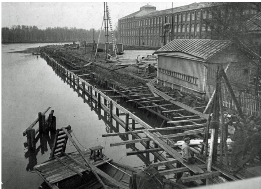
Pohjoisrannan laituria rakennetaan tai uusitaan. Lähde: Puuvillatehtaan arkisto, Renor Oy, Pori.
