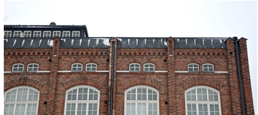
Itäkulman julkisivun yläosaa, räystään hammaslistaa. Pilastereiden jatkuminen yli räystään ja terävä päate on uusgotiikkaan liittyvä piirre, 1910- ja 1930-lukujen muutosten jyrkkä kattomuoto vie osansa piirteiden vaikuttavuudesta. Ensimmäisessä vaiheessa, 1890-luvulla tehtaiden kattomuotona oli vielä loiva aumakatto.
