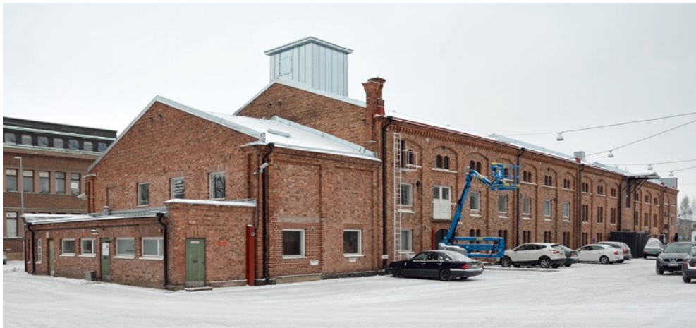
Kuva on otettu kaakosta luoteeseen päin. Kangasvaraston, ruokalan ja värjäämörivin julkisivujen yläosissa on edelleen kiinnikkeet rakennusten välisille ripustetuille valaisinvaljeille.
