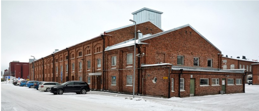
Tehdaskorttelin länsijulkisivu, Kangasvaraston eteläpääty, jonka jatkeeksi rakennettiin 1922 kaksikerroksinen pakkaamo ja 1934 yksikerroksinen portinvartijan ja varaston sisältämä rakennusosa. Kuva on otettu lounaasta koilliseen päin.
