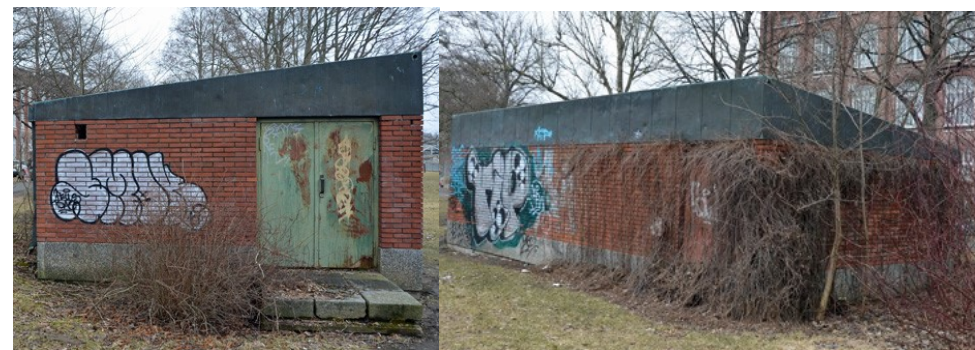
Puistoalueella sijaitseva pumppurakennus lännestä ja kaakosta.
