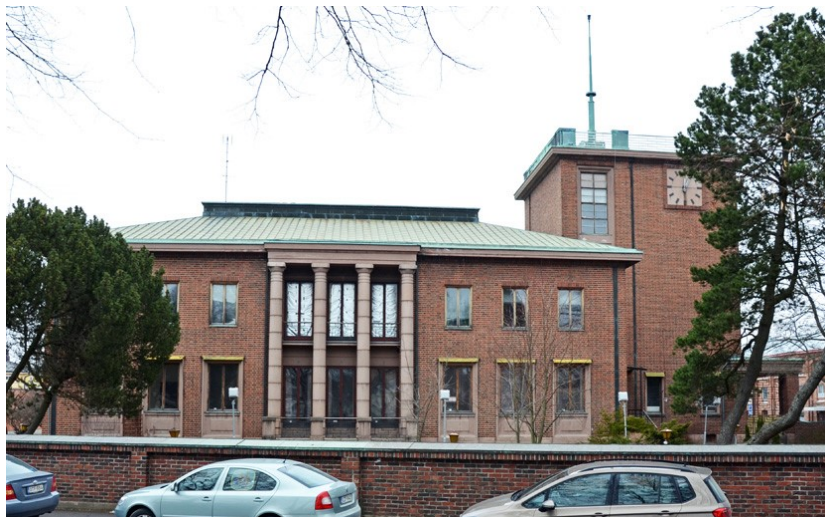
Johtajan asunto, konttorirakennus ja puisto sekä tiilimuuri eteläpuolelta kuvattuna.
