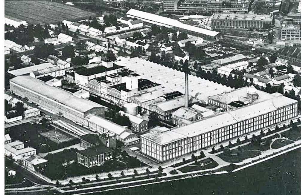
1950–60-lukujen vaihteen ilmakuvasta näkyy, kuinka tehdasalue on rakennettu aivan täyteen. Rakentaminen eteni korttelissa 1900-luvun alusta lähtien kohti pohjoista. Tehdasaluetta leimaakin kehräämöstä kohti pohjoista suuntautuvat pitkät rakennusmassat. Uudisrakentaminen olisi käytännössä tarkoittanut vanhan purkamista. Vähän lisätilaa saatiin vielä tehtaan jatkeena olevasta asuinkorttelista, johon rakennettiin yksittäisiä varastorakennuksia. Käytännössä tehtaan lisätila haettiin Ikaalisista, johon perustettiin tehtaan silkiosasto. 1960-luvulla vanhojen tehtaiden laajenemismahdollisuudet kaventuivat, syynä oli kaupungistuminen sekä tehtaiden vaatimien uudistusten suurempi mittakaava. Vesiliikenteen merkitys väheni 1950-luvulla Suomen autoistuessa ja tehtaan etupihana, kuljetus-, laiturij- ja varastoalueena ollut Pohjoisranta sai tällöin nykyisen puiston. Lähde: Elka.
