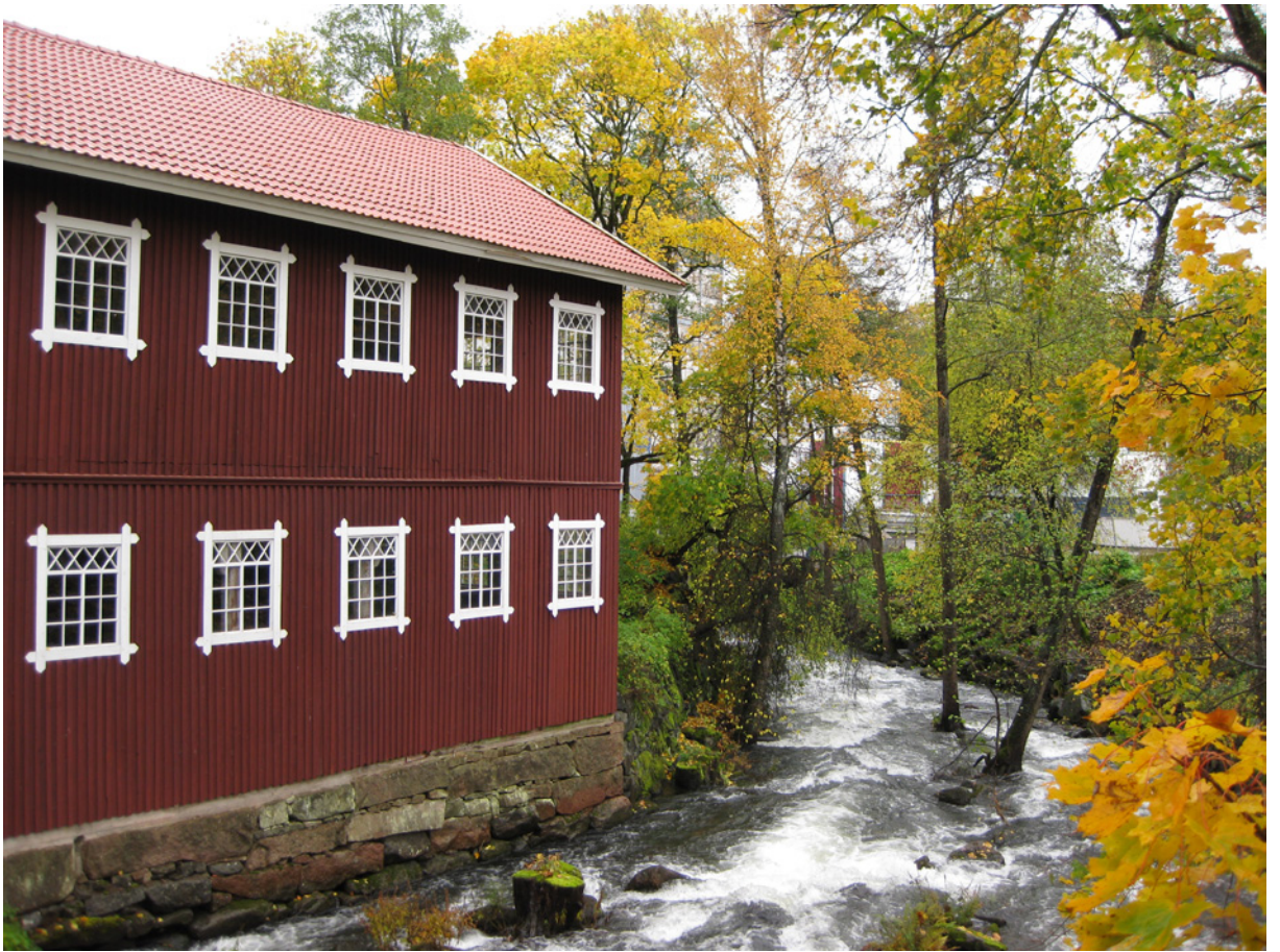
Kuva 14. Kauttuan saha. Satakunnan Museo/Niina Uusi-Seppä, 2008
