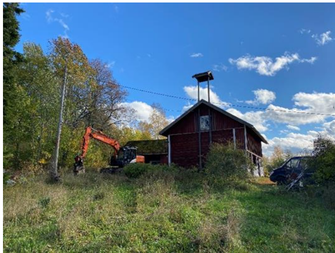
Maatilan talousrakennus kiinteistöllä 413-408-6-49 KALLIO.
