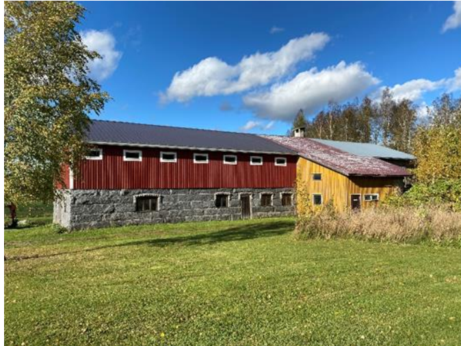
Osin kiinteistön 413-408-6-49 KALLIO alueella sijaitseva vanha navettarakennus.
