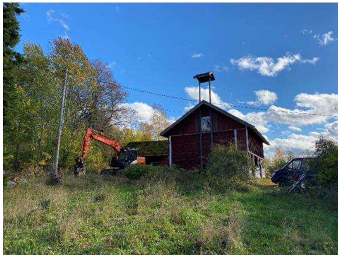
Maatilan talousrakennus kiinteistöllä 413-408-6-49 KALLIO.
