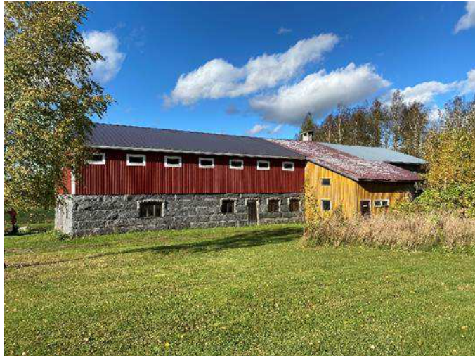
Osin kiinteistön 413-408-6-49 KALLIO alueella sijaitseva vanha navettarakennus.
