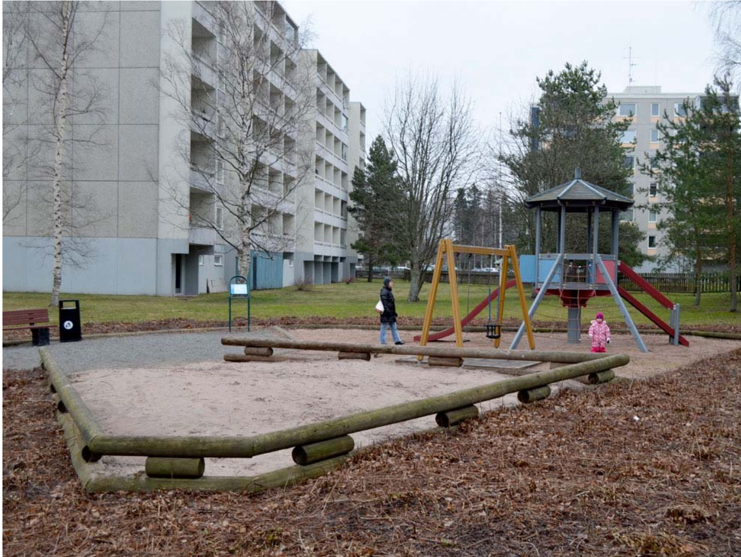
Kuva 15. Kuusikerroksisia kerrostaloja havupuiden suojassa ja ilman suojaa Suopuiston leikkipaikan ympärillä. Kuva: Porin kaupunki
