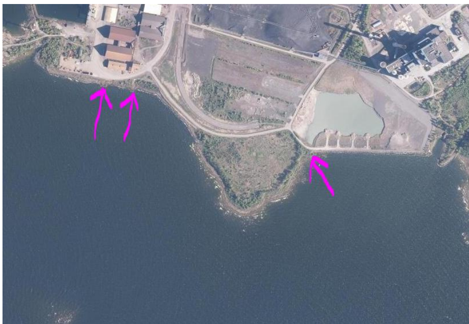
Kuva 5. Hankealueelle sijoittuvat Tahkoluodon hulevesiviemärien purkupaikat
