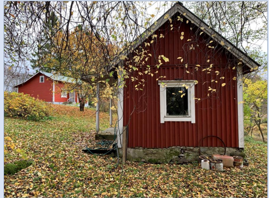
Vapaa-ajankäytössä olevan vanhan kalastajatalon rakennuksia.
