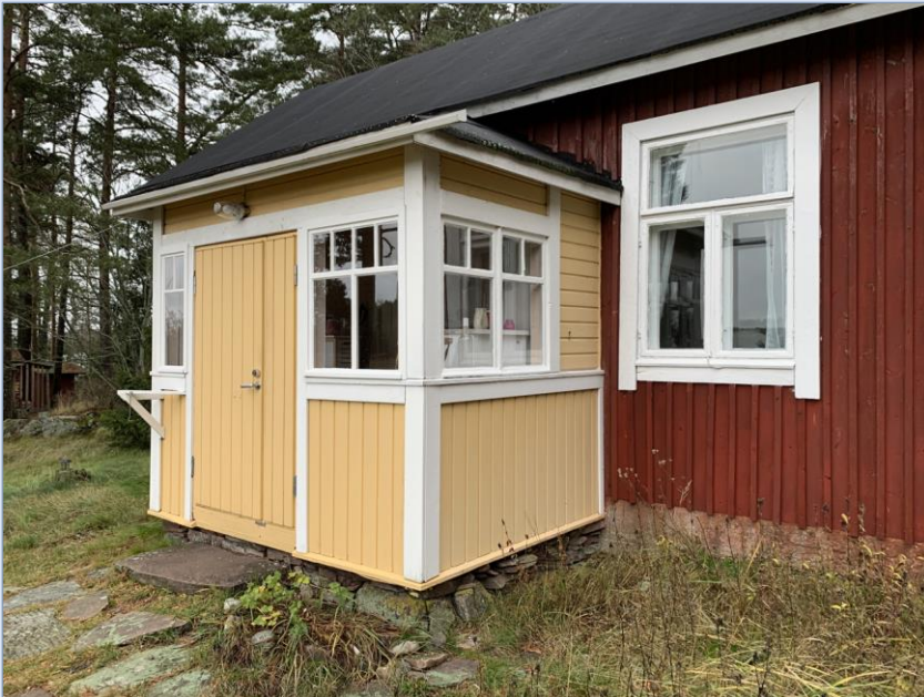
Puuikkunat on kunnostettu ja kuisti maalattu.
