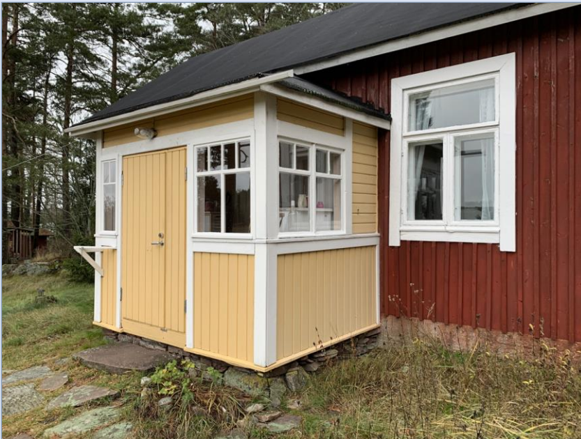
Puuikkunat on kunnostettu ja kuisti maalattu.
