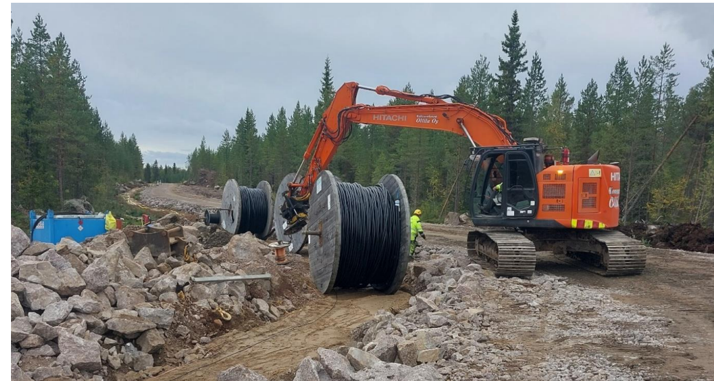
Maakaapelien asennustyö käynnissä. (Kuva J. Silvola, Ramboll)
