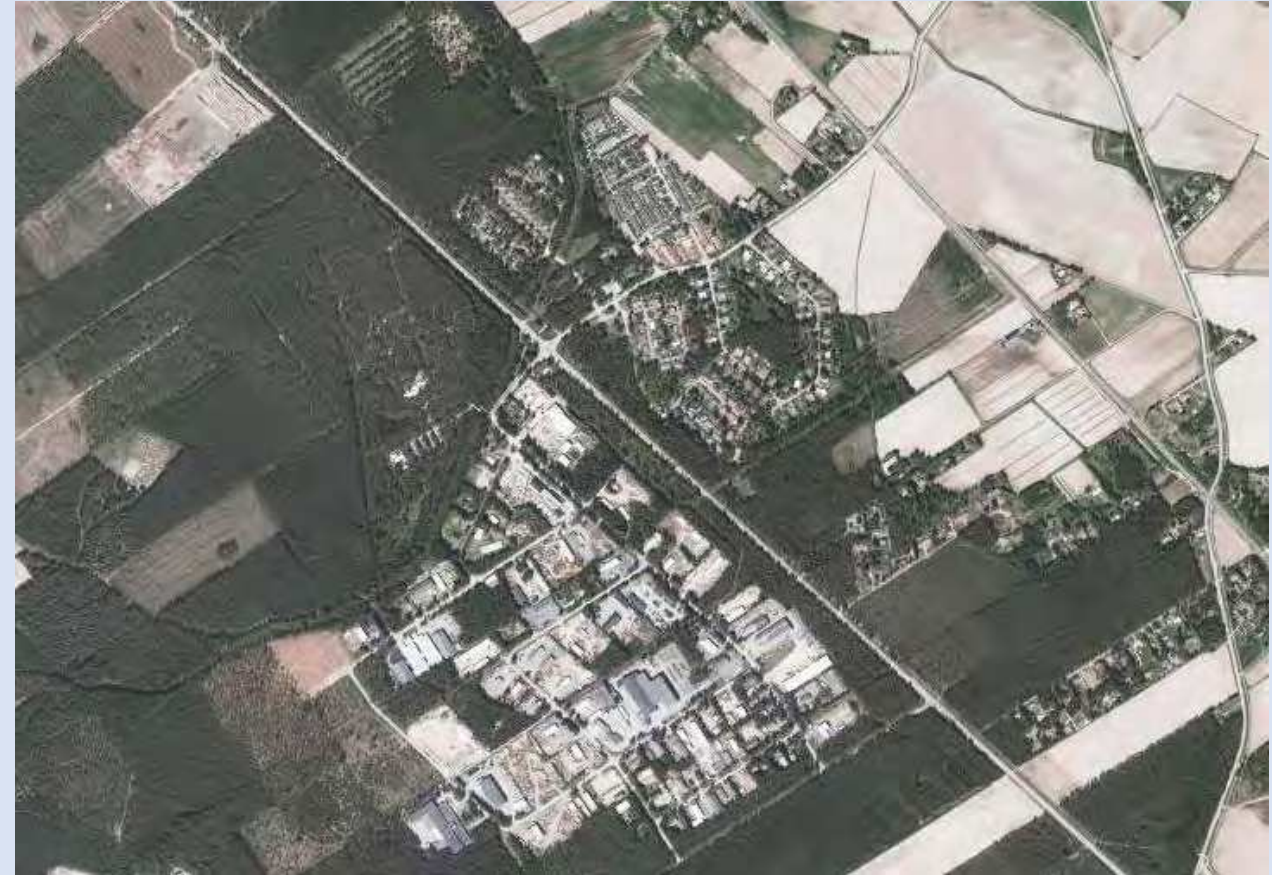
Uusiniitty ilmakuvassa 2022. Alue rakentui pääosin 1970-luvulla, ja asuinrakennukset keskittyvät Mäntyluodontien pohjoispuolelle. Uudenniityn pienteollisuusalue ja Metsähautausmaa sijaitsevat Mäntyluodontien eteläpuolella. Kuva: Paikkatietoikkuna/historialliset ilmakuvat.
