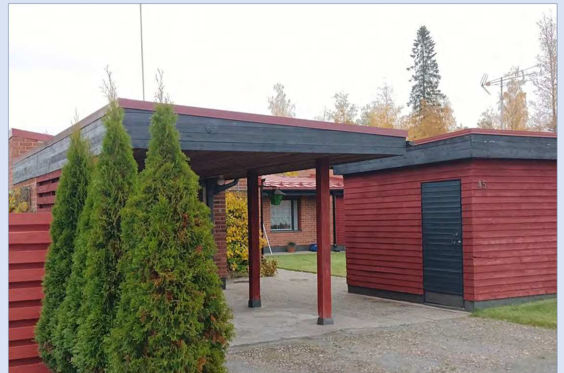
Tiilipintaisiin asuinrakennuksiin liittyy puisia katoksia ja varasto-osia.
