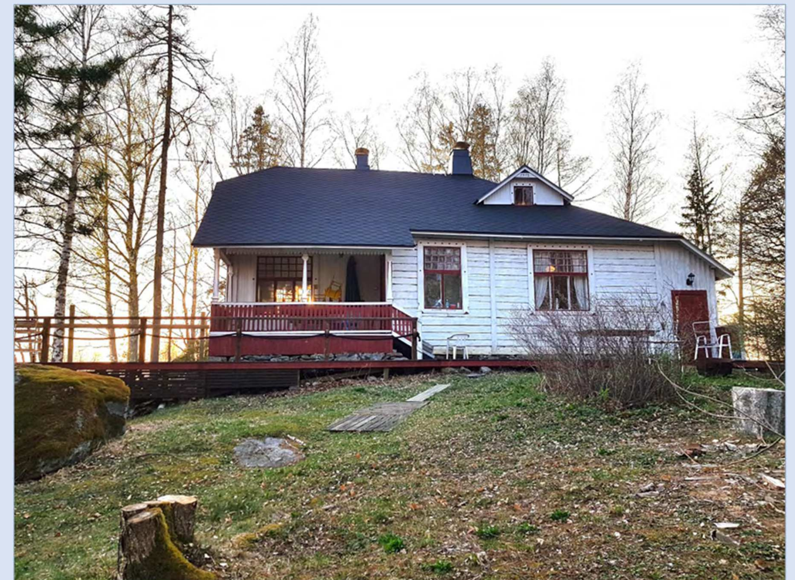
Alun perin 1880-luvulla rakennettu Loisto ja vuonna 1912 rakennettu Pikku-Loisto edustavat Pihlavanlahden varhaista huvilakulttuuria.
