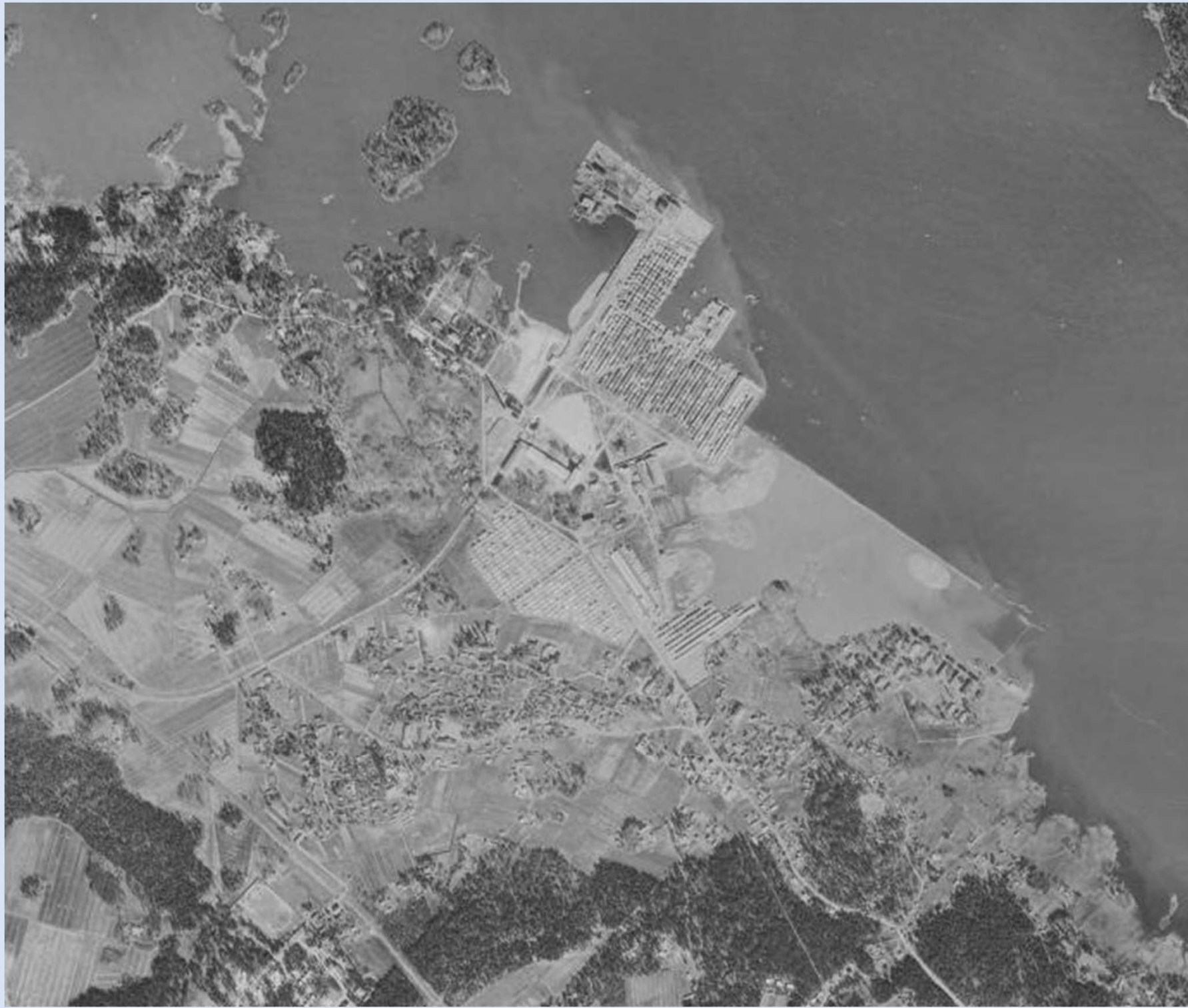
Pihlava vuonna 1958. Alueen teollisuus on jo keskittynyt pohjoiseen, niemenkärkeen. Asutus sen sijaan on sijoittunut etelämmäs. Nykyisen Rieskalan palvelukeskuksen paikalla on vielä peltomaata. Kuva: Paikkatietoikkuna/Historialliset ilmakuvat.
