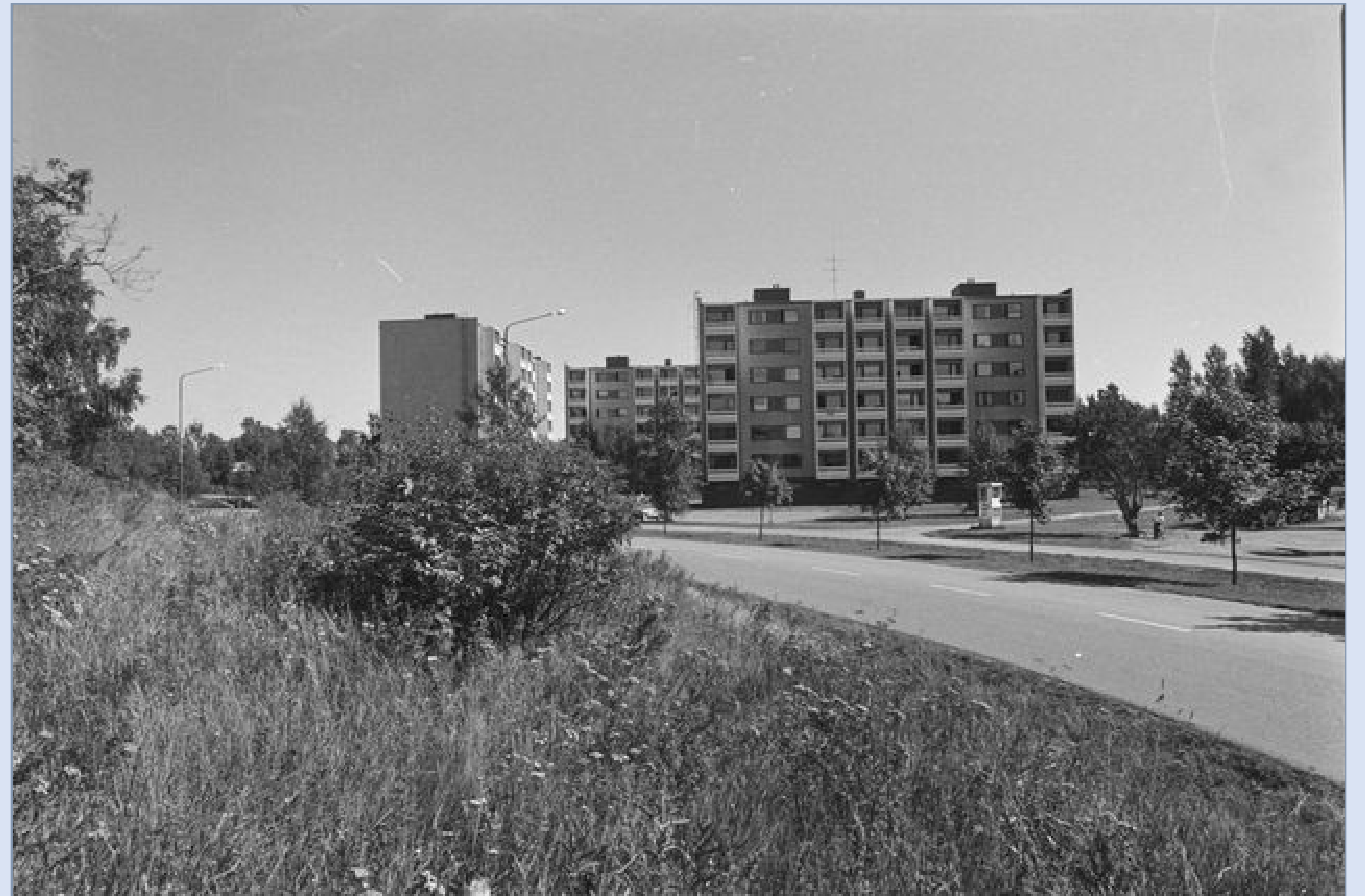
Pihlavasta kasvoi Porin maalaiskunnan kookkain keskus ja Yyterinniemen teollisuus vauhditti alueen kehitystä vielä kuntaliitoksen jälkeenkin. Pihlavaan rakennettiin 1970-luvun alussa asuinkerrostaloja mm. Pihlavan Tehtaiden, Rauma-Repolan ja Kemiran työntekijöille. Kuva: Veli-Matti Lähteenmäki/Satakunnan Kansan kuva-arkisto.
