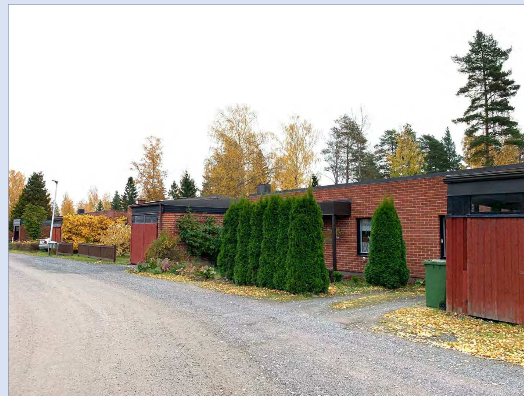
Mestarintien omakotitalojen puhtaaksi muurattua tiilipintaa.
