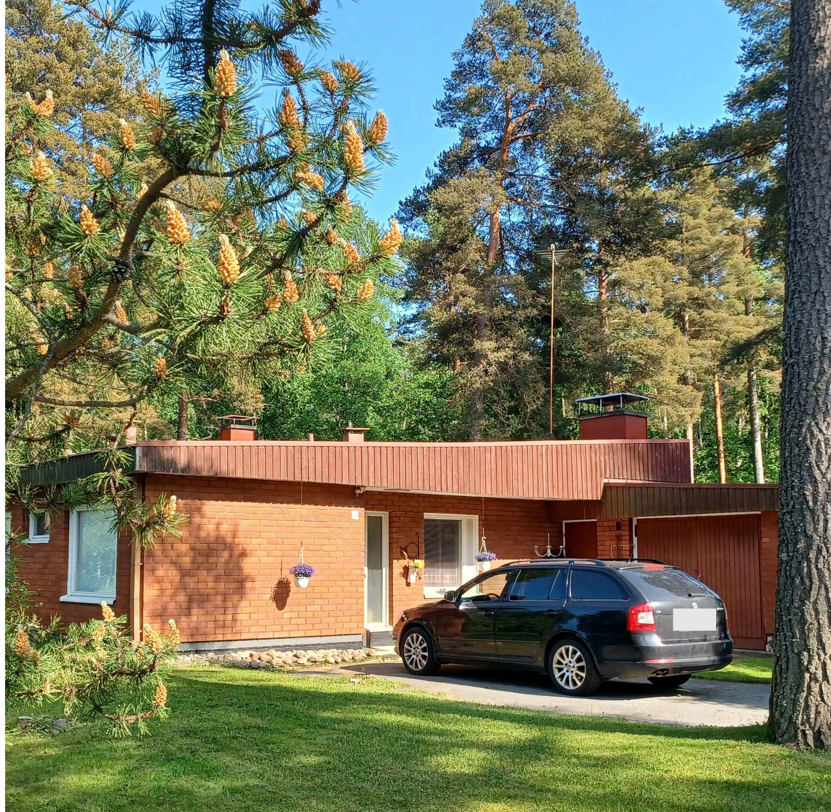
Uudenniityn Nevanpellontien ja Uusitien varrelle muodostunut asuinalue koostuu keskenään samanlaisista, pulpettikattoisista, yksikerroksista asuinrakennuksista, joiden etualalla on autotalli. Alue on puutarhamainen ja rehevä. Kuvat: Sanna Kuusikari
