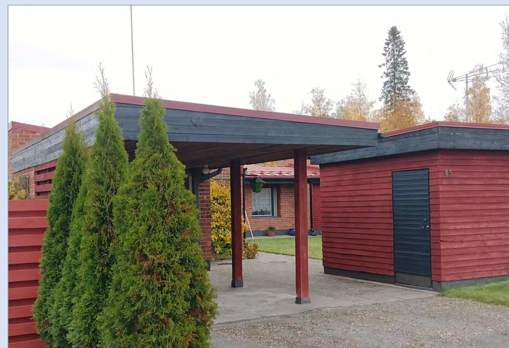
Tiilipintaisiin asuinrakennuksiin liittyy puisia katoksia ja varasto-osia.
