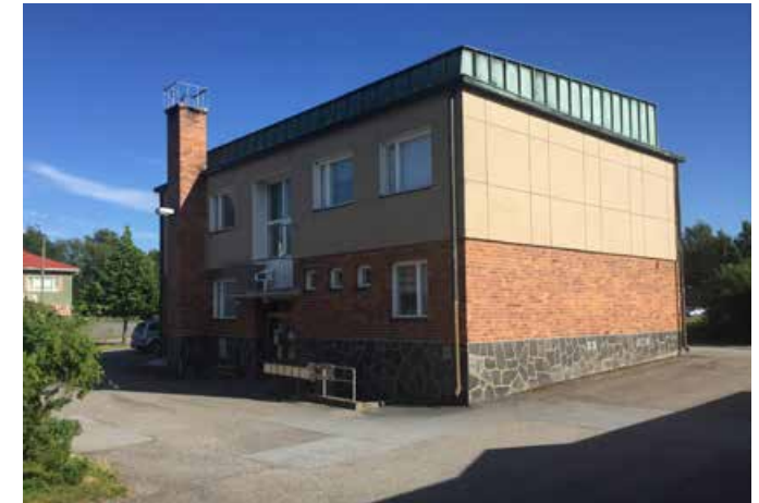
Julkisivu pihalle. Kuva Helene Kaarnametsä 2020.
