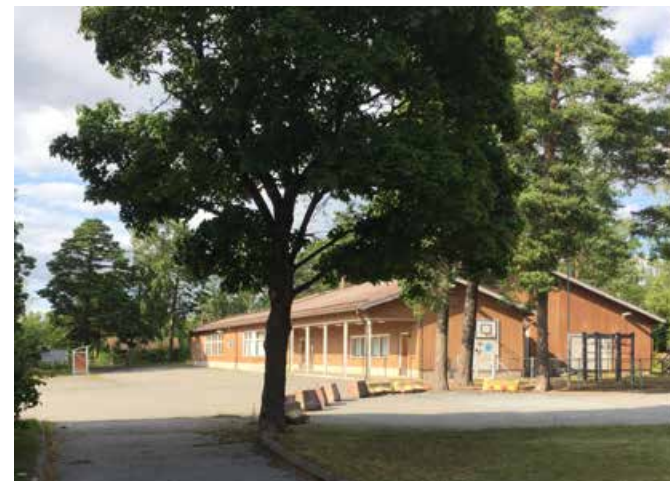
Nuorin, vuonna 1982 valmistunut koulurakennus on purettu talvella 2021.
