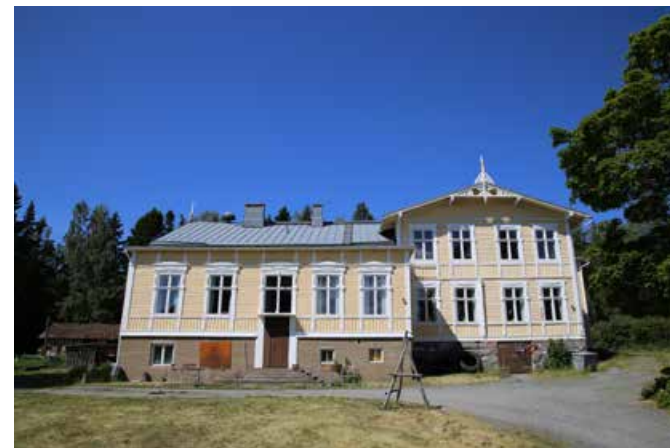
Rakennuksen julkisivuun on tehty huomattavia muutoksia koulun aikana. Kuva Veera Saastamoinen 2020.
