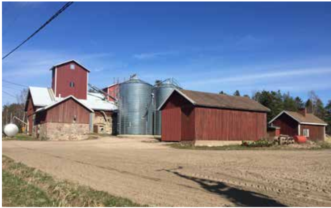
Preiviikintien tuntumassa on runsaasti maanviljelykseen liittyviä rakennuksia. Kuva Helene Kaarnametsä 2020.
