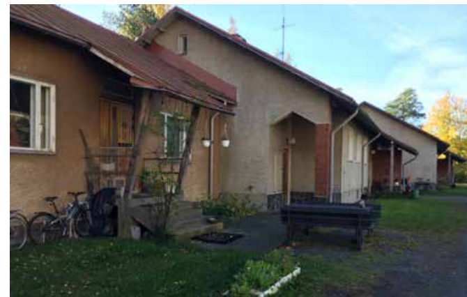
Henkilökunnalle vuonna 1957 rakennettu kuuden asunnon rivitalo. Kuva Helene Kaarnametsä 2018.
