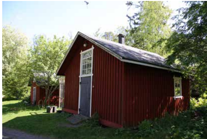
Ulkorakennuksia. Kuva Veera Saastamoinen 2020.
