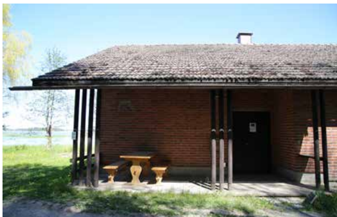
Sisäänkäyntejä suojaavat puupylväillä tuetut katokset. Kuvat Veera Saastamoinen 2020.
