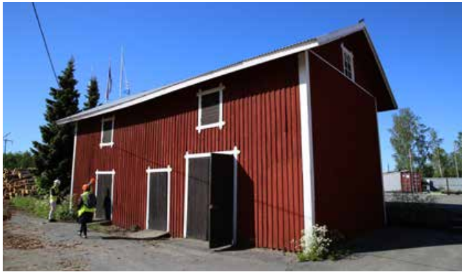
1910-luvulla rakennettu varastorakennus. Kuva Veera Saastamoinen 2020.
