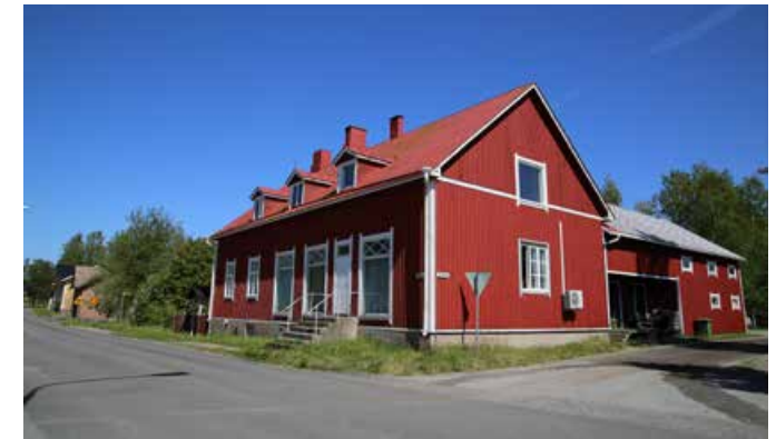
Mörtintien varrella on entisiä kauppoja, jotka on muutettu asuinkäyttöön.
