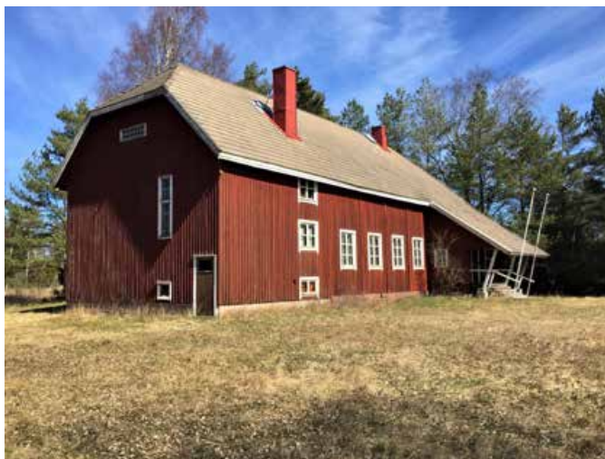
Rakennusta on laajennettu 1950-luvulla ja samalla alkuperäinen kuisti on poistettu. Pystysuuntaisella ikkunarivillä varustettu laajennusosa etualalla. Kuva Helene Kaarnametsä 2020.
