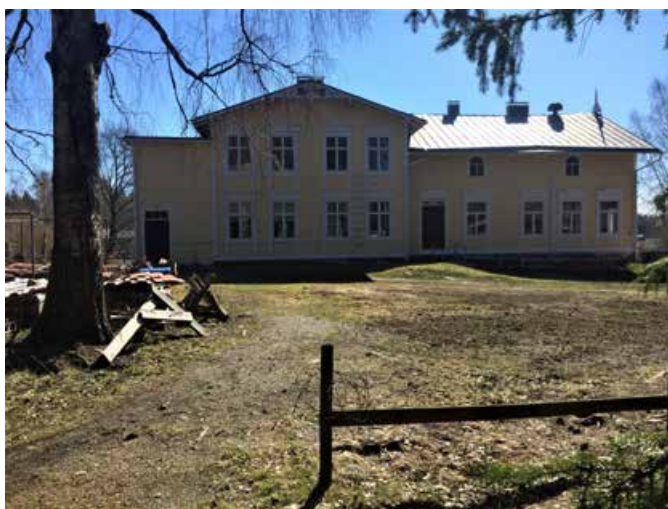
Julkisivu luoteeseen. Kuva Helene Kaarnametsä 2020.
