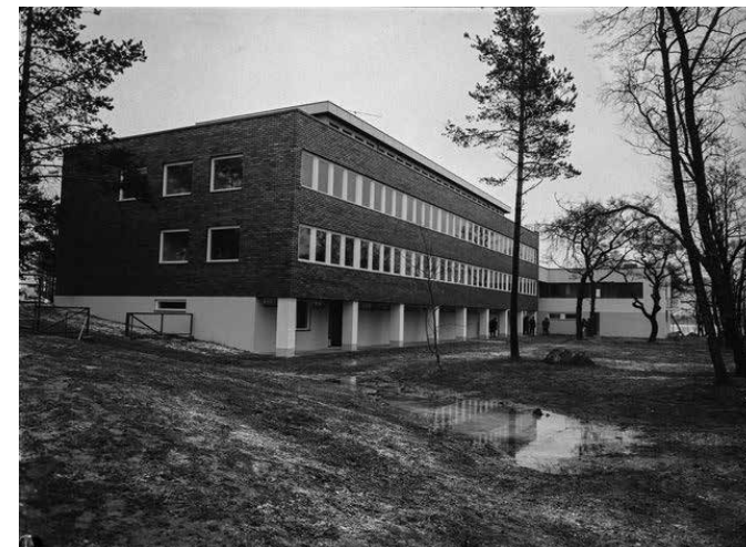
Nauhaikkunat merelle. Kuva Satakunnan Kansa 1963.
