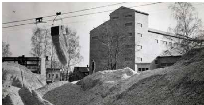
Kuitulevytehdas. Kuva A. Ahlströmin arkisto.
