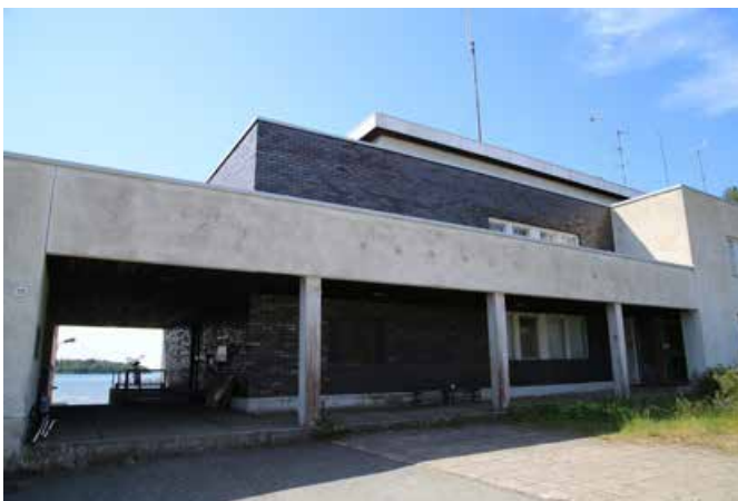
Osa nauhaikkunoista on peitetty (vertaa kuva yläpuolella). Kuva Veera Saastamoinen 2020.
