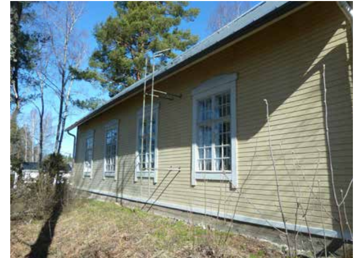
Alkuperäiset ikkunat ovat säilyneet. Kuva Heimo Salminen 2020.
