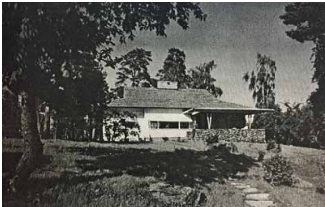
Tehtaanjohtajan talo. Kuva kirjasta Suomen teollisuuden arkkitehtuuria (1952).
