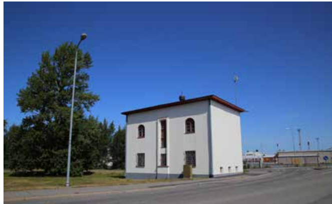
Muuntoasema taustallaan satama. Kuva Veera Saastamoinen 2020.
