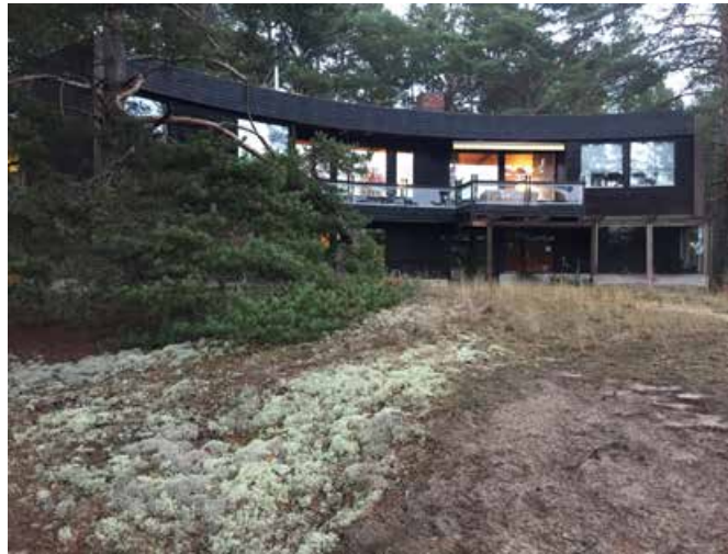
Pookintie 11:n kaareva julkisivu. Kuva Helene Kaarnametsä 2020.
