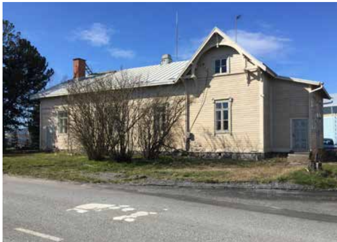
Julkisivu etelään. Kuva Helene Kaarnametsä 2020.
