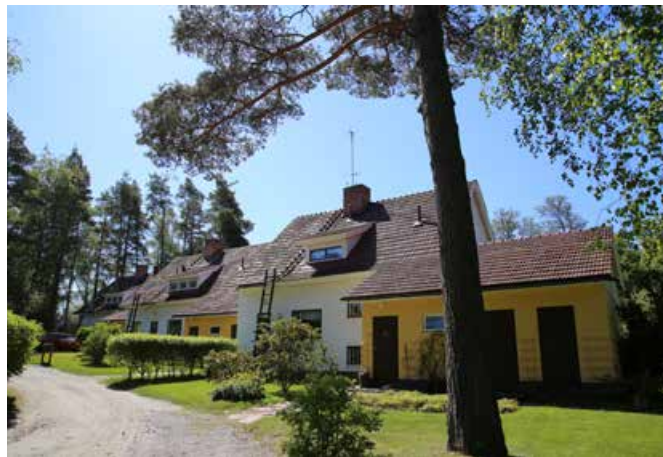
Rakennus polveilee maaston mukaisesti. Kuva Veera Saastamoinen 2020.
