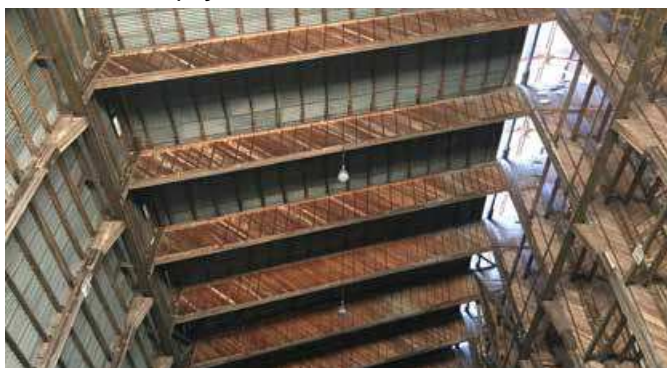
Ison suulin kattorakenteita. Kuvat Helene Kaarnametsä 2020.
