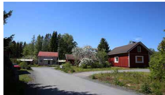
Lantintien ja Isokivenkujan rakennuksia. Kuvat Veera Saastamoinen 2020.
