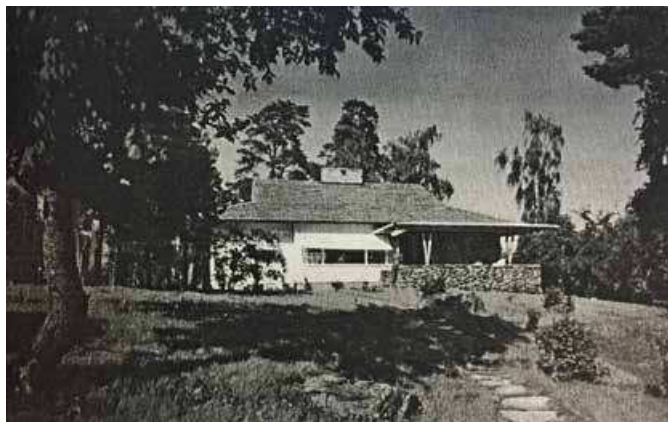
Tehtaanjohtajan talo. Kuva kirjasta Suomen teollisuuden arkkitehtuuria (1952).
