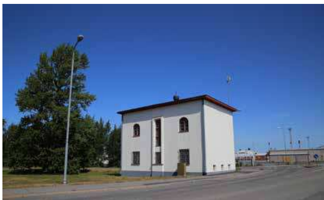
Muuntoasema taustallaan satama. Kuva Veera Saastamoinen 2020.
