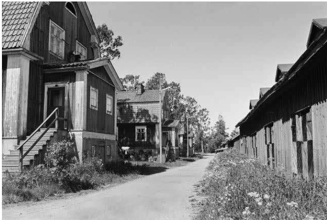
Ennen peruskorjausta. Kuva Satakunnan Kansa.
