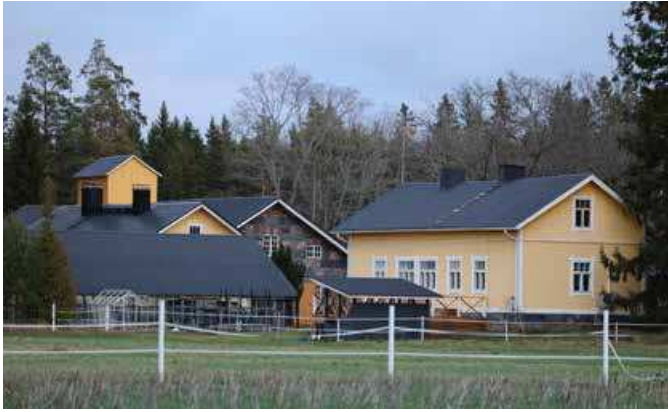
Kasvihuone, navetta-talli ja asuinrakennus.
