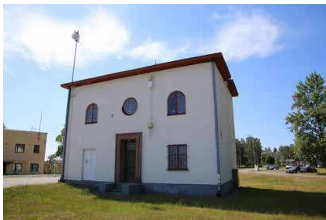
Muuntoasema Satamakadun varrella. Kuva Veera Saastamoinen 2020.
