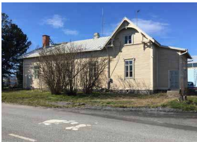
Julkisivu etelään. Kuva Helene Kaarnametsä 2020.
