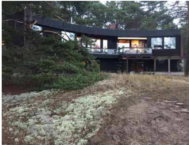
Pookintie 11:n kaareva julkisivu. Kuva Helene Kaarnametsä 2020.
